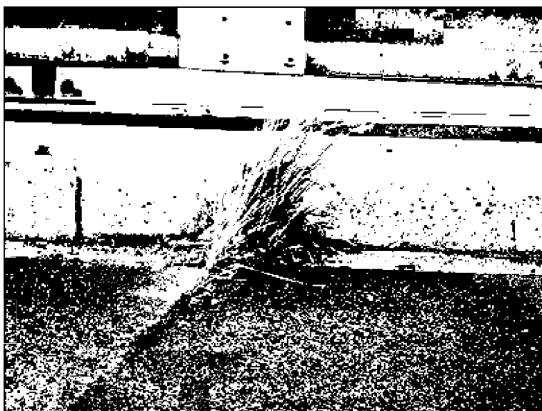
2.3_Mostní závěr na PM nad O2 - vlevo uchycená vegetace.JPG
