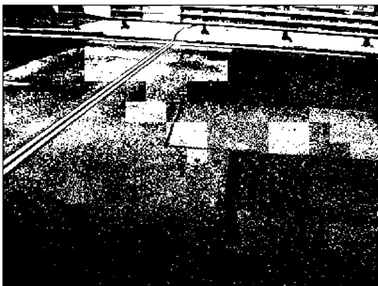
3.1_Vozovka opravená a opět poškozená.JPG
