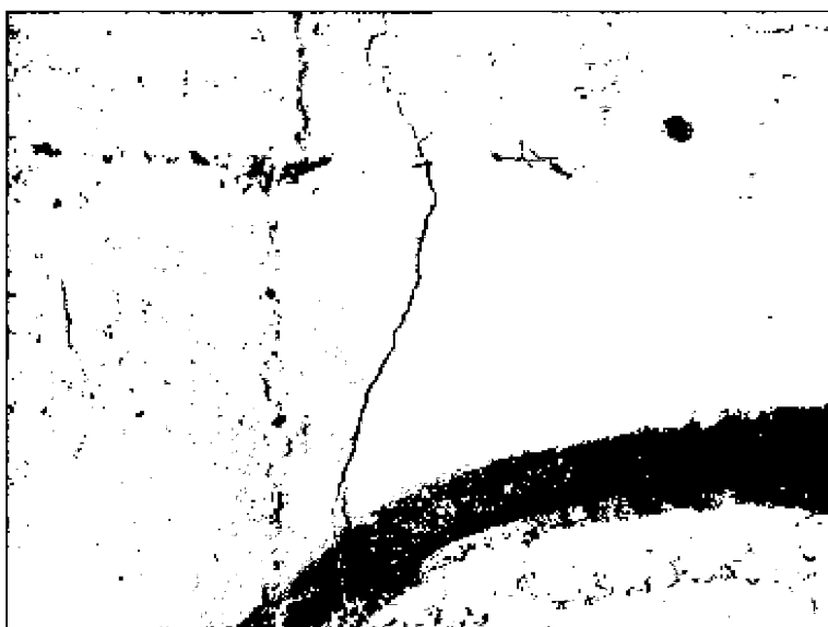
1.2_O2 - trhlina v dřívku opěry.jpg
