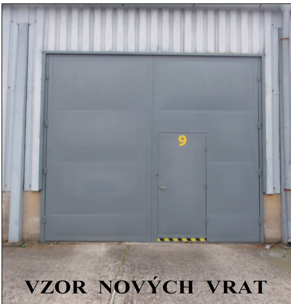
Foto č. 4- výměna vrat SO č. 069
