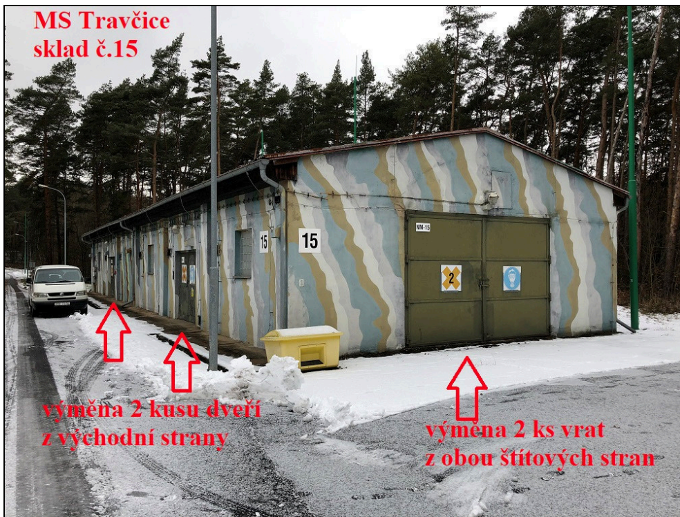
Foto č. 3 – Výměna vrat skladu munice, SO č. 15
