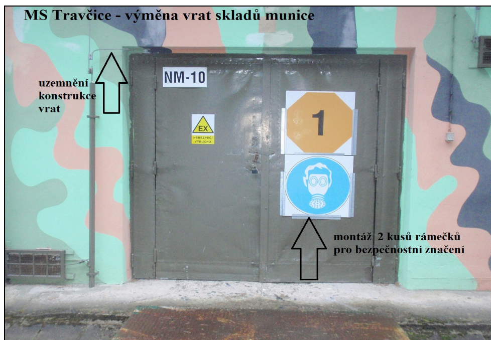
Foto č. 2– Výměna vrat skladů munice, SO č. 6, 7, 8, 15, a 22
