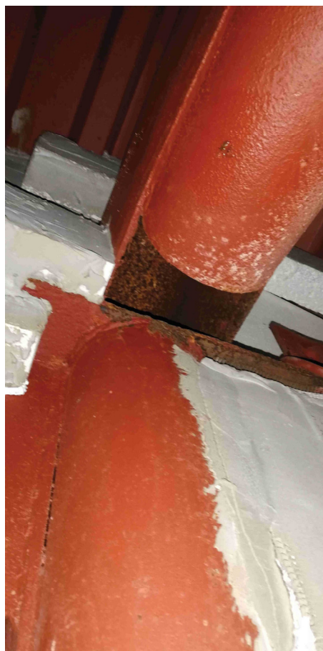
9.4 – Pohled na uložení vazníku v jižní části (první na západní straně)
