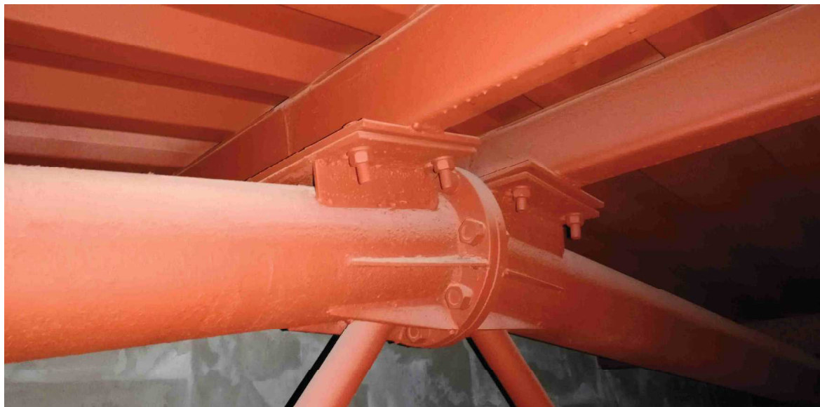
Obr. 9.1 – Pohled na vazník ve vrcholu
