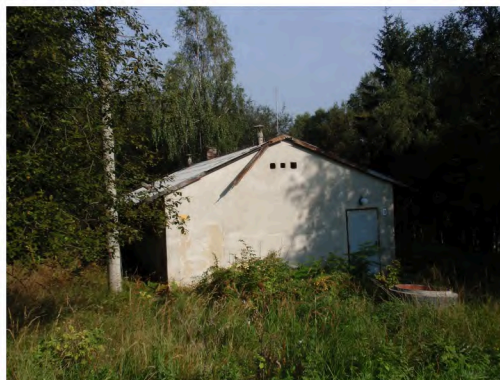
Objekt č.022 – WC
