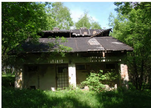
Objekt č.013 – Umyvárna
