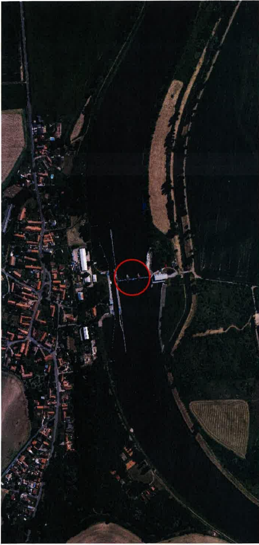
VD Kostomlátky, oprava spodní stavby jezu, potápěčské práce
