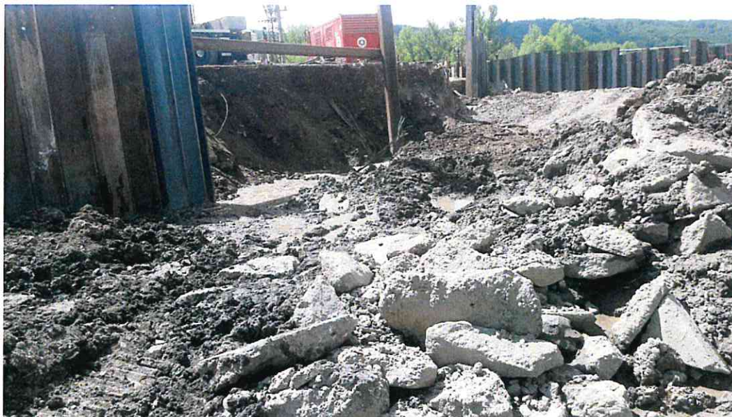
Obrázek 2: Vytažené úlomky panelů v prostorách hlavního jezového tělesa 21.5.
