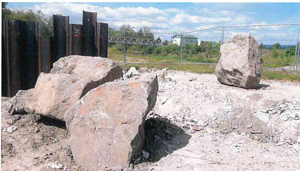
Obrázek 2: Vytažené úlomky panelů v prostorách hlavního jezového tělesa 21.5.
