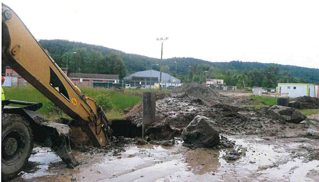
Obrázek 3: Hloubení prohrábky v trase štětovnic v nadjezí 11. 6.
