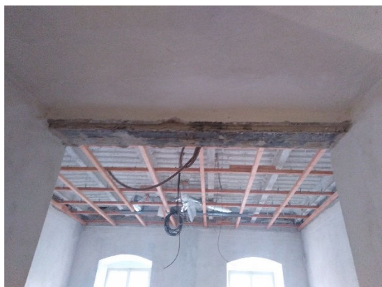
Změna 4.6. Přesekání I-překladů dveří ve 2.NP
