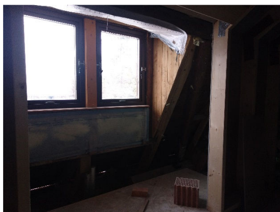
Změna 4.8. Výdřeva pro nůžkové mříže
