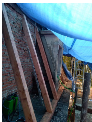
Změna č. 4.13. Výměna střešní vazby na mansardové střešd dvoupodlažní přístavby
