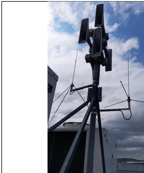
Obr. ESH.5-1 – 8 ozvučnic na stávajícím stožáru
