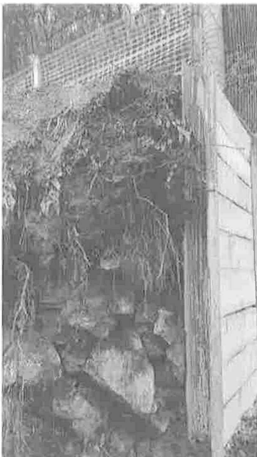
Foto č.1 – zeď skládaná na sucho v místě záporny
