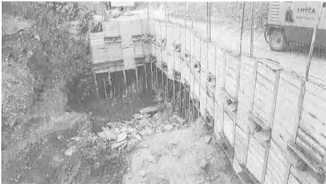
Foto č.2 – pohled na záporové pažení u OP4 s polohou výchozu podložních hornin
