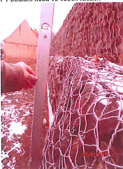
F2 boulení 1. řady gabionu
