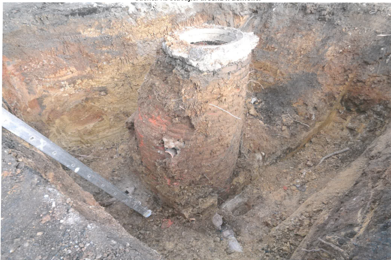
Šachta Rš stávající určena k demolici
