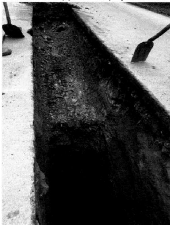
Obr. 2 – celkový pohled na výkop KŠ10-KŠ11 Obr. 3 – výkop šachty KŠ11
