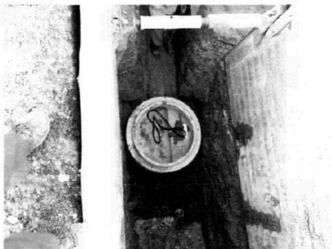
Obr.6 – výkop šachty KŠ12
