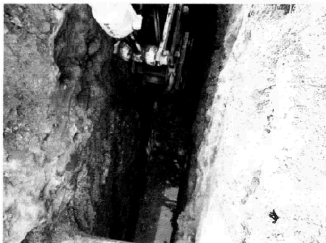
Obr. 5 – výkop mezi KŠ11-KŠ12
