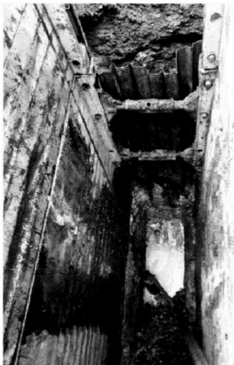
Obr. 1 – celkový pohled na výkop
