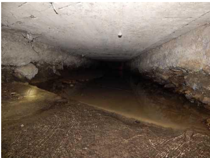
Pohled do mostního otvoru zprava
