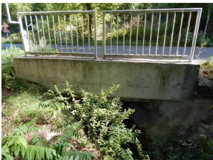
Pohled na pravou stranu mostu
