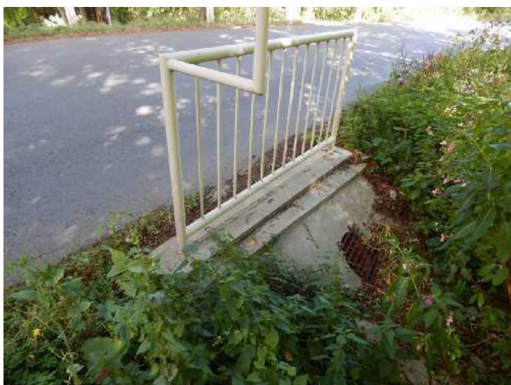
Pohled na levou stranu mostu
