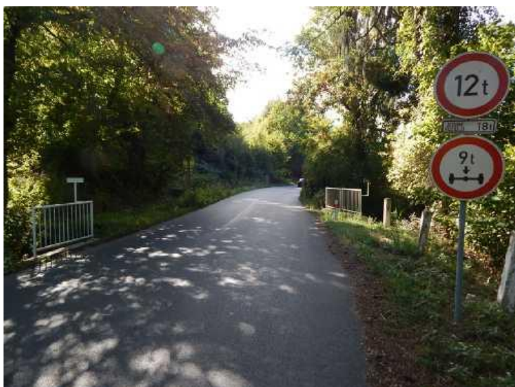
Pohled na most ve směru staničení
