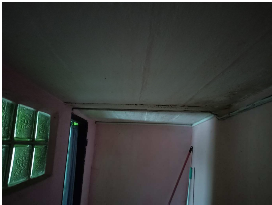
Stropní konstrukce hlavní budovy, betonová skládaná konstrukce do ocelových nosníků. Stav a případná korozie bude posouzena podrobným průzkumem při stavebních úpravách.
