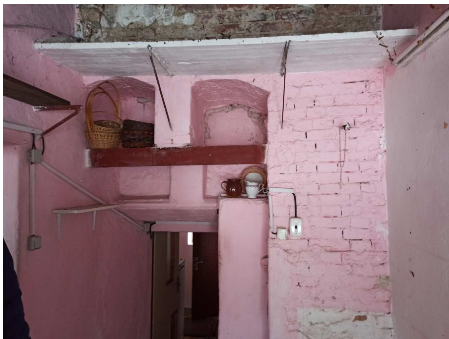
Propojovací část mezi zahradou a uliční částí pozemku bez viditelných poškození
