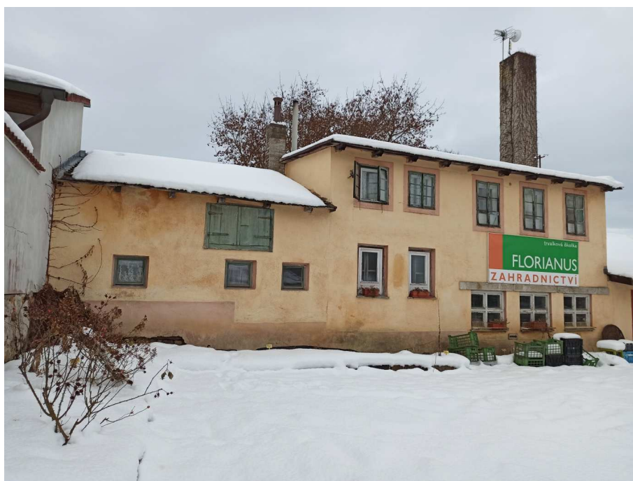
Čelní pohled na dvoupodlažní část s přístavbou k sousednímu objektu
