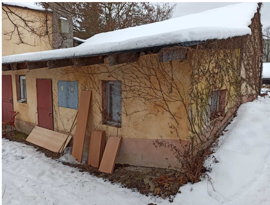
Boční přístavba s pultovou střechou
