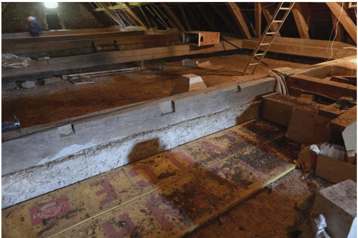
36. západní křídlo, půda, střední část vazného trámu vazby 21
