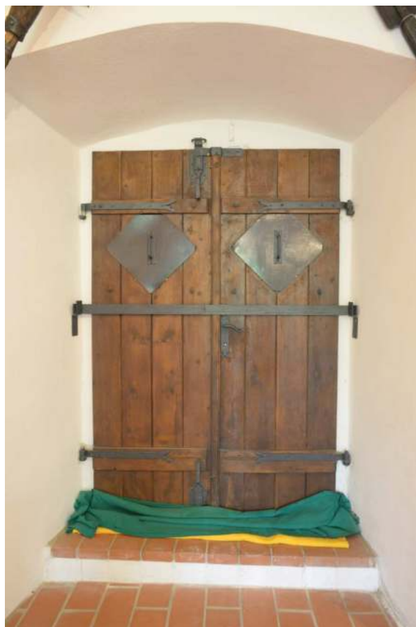
30. západní křídlo, severní čtvercová místnost, vstup v západní stěně
