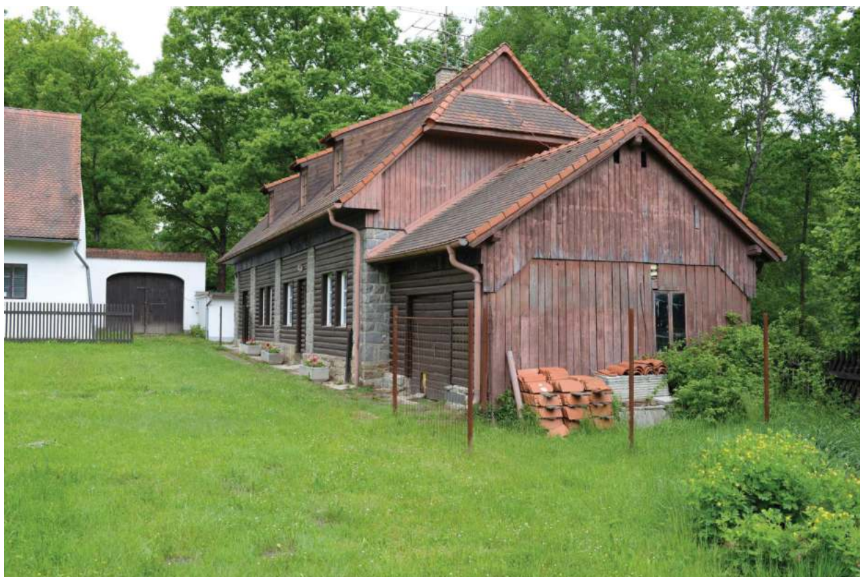
50. severní křídlo (novodobá provozní budova), celkový pohled od východu
