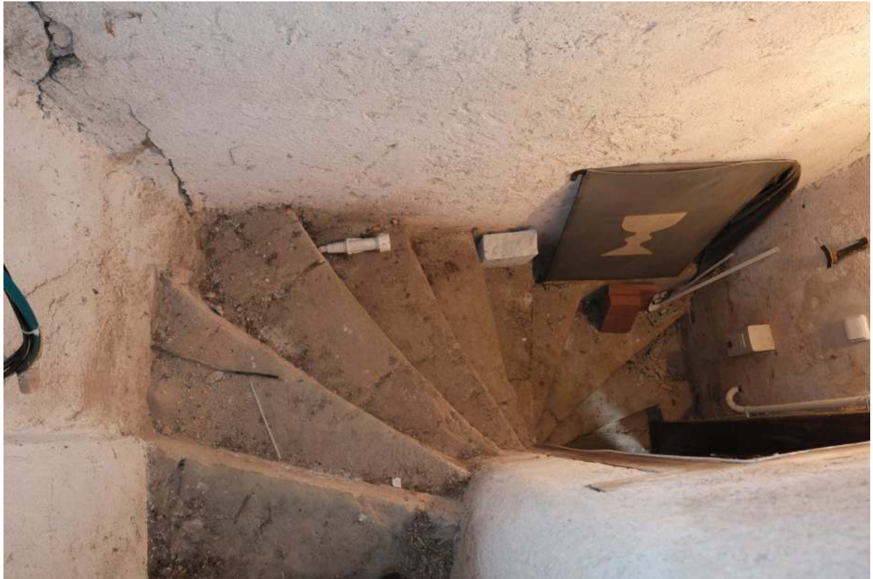
35. západní křídlo, schody na půdu
