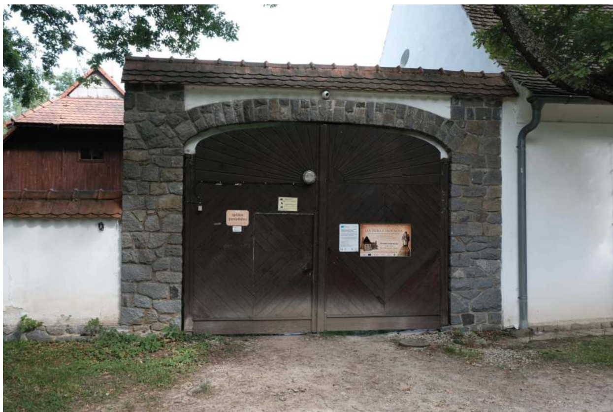
45. západní křídlo, vjezd, pohled od západu
