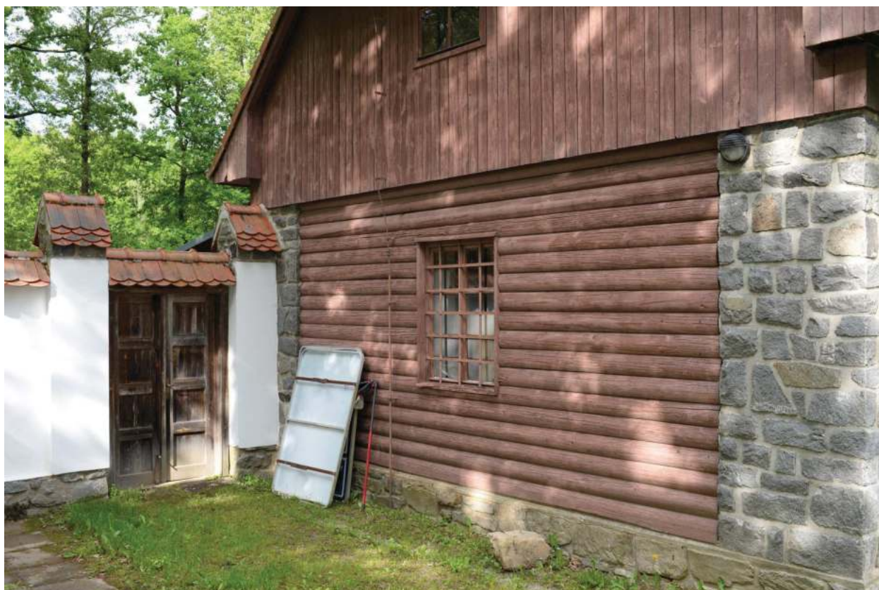
48. severní křídlo, západní průčelí novodobé provozní budovy
