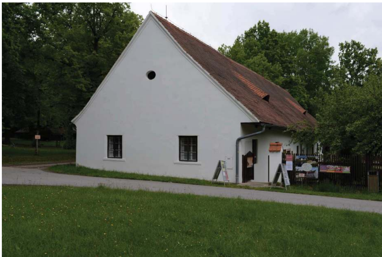
7. západní křídlo, jižní průčelí
