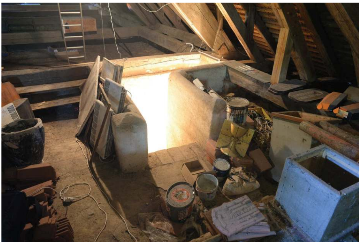
34. západní křídlo, půda, část se schody z přízemí
