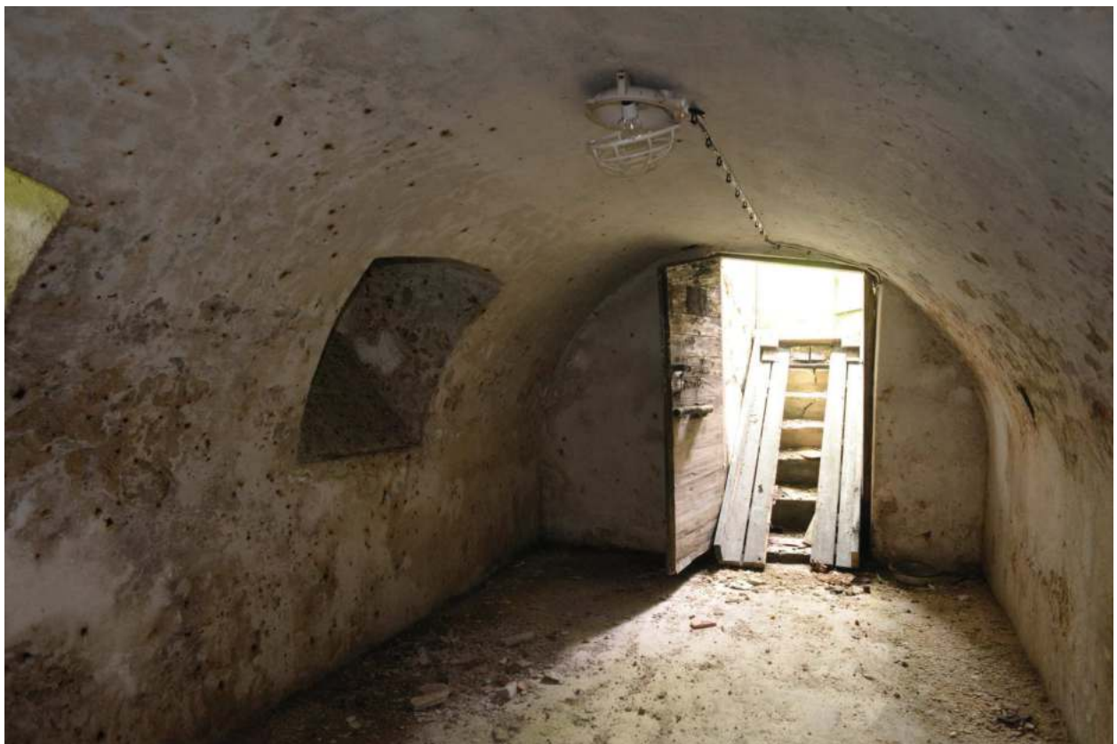
52. východní křídlo, sklep na jižní straně zaniklé stodoly, západní část se vstupem
