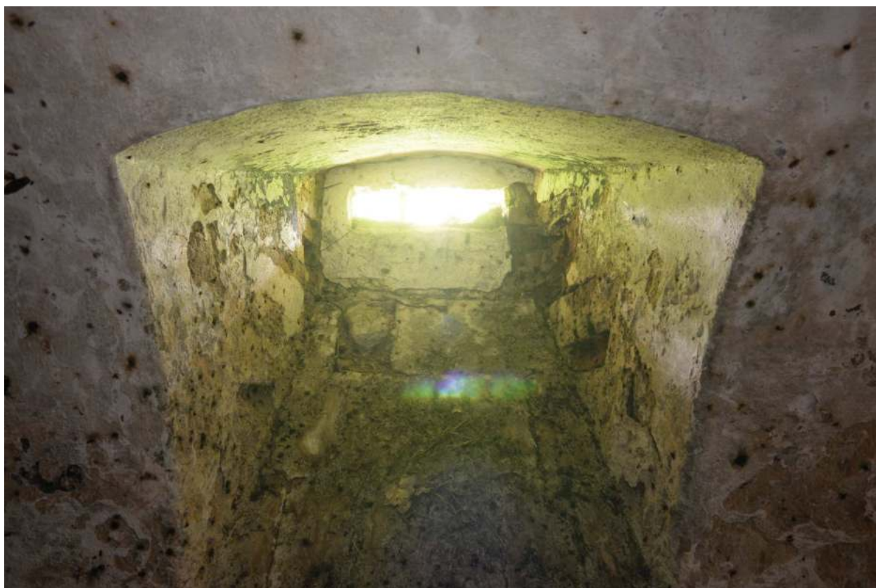
54. východní křídlo, sklep na jižní straně zaniklé stodoly, západní větrací otvor v jižní stěně
