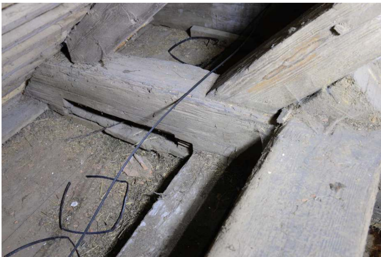
40. západní křídlo, půda, vazný trám vazby 19 na východní straně v místě odstraněného vikýře
