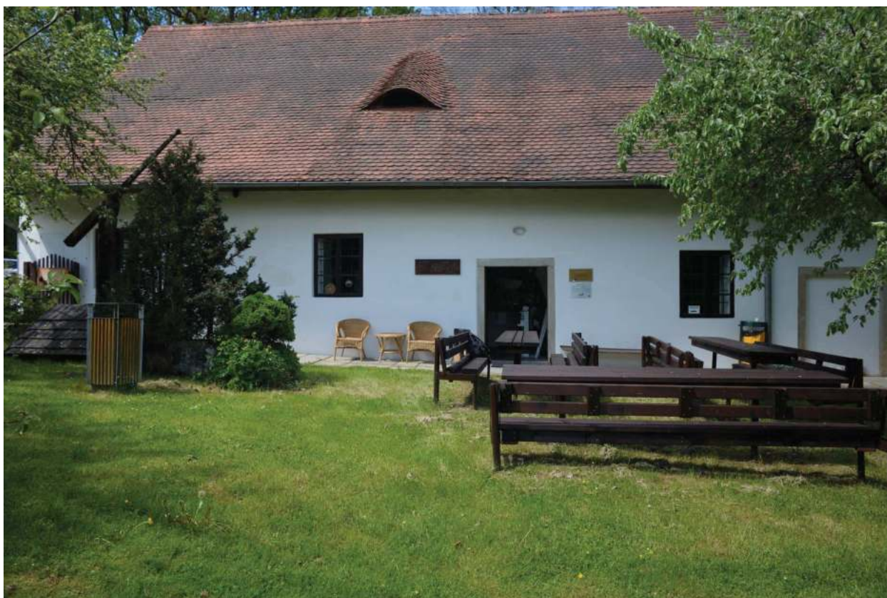
10. západní křídlo, jižní část východního průčelí
