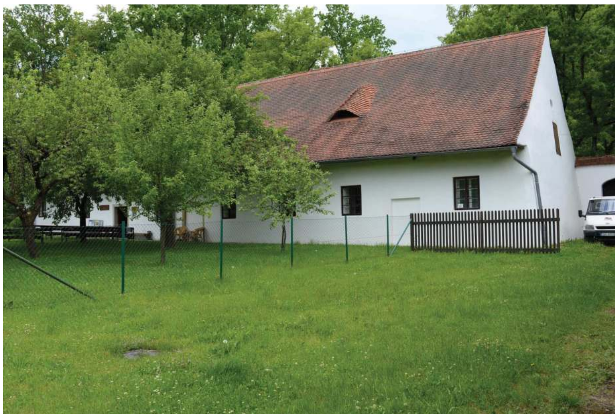
12. západní křídlo, celkový pohled od severovýchodu
