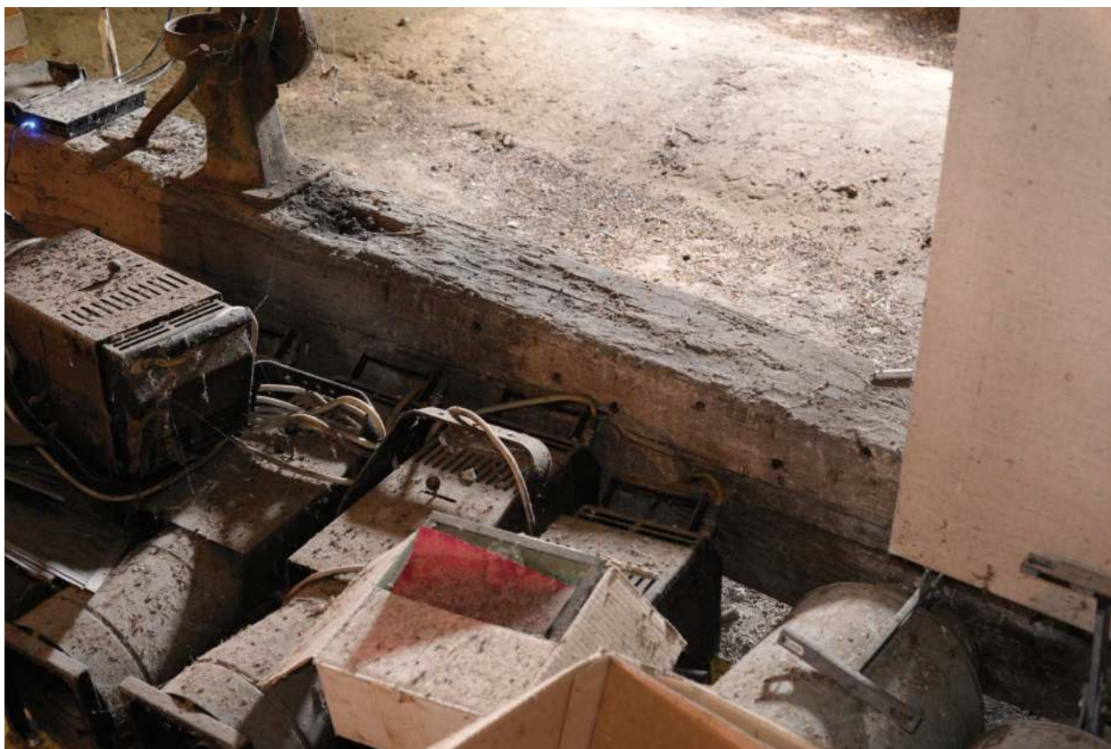
33. západní křídlo, půda, střední část vazného trámu vazby 29
