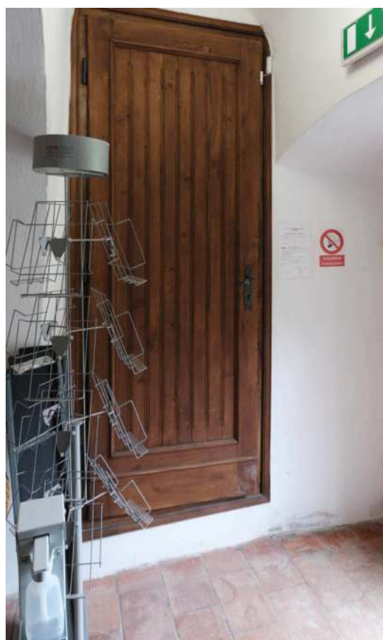
20. západní křídlo, jižní obdélná místnost, vstup na schody na půdu v severní stěně
