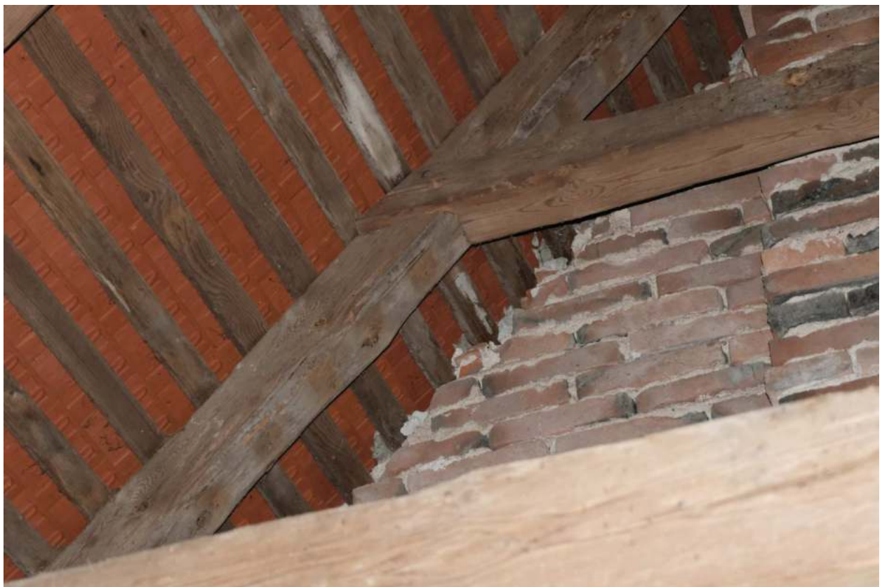
44. západní křídlo, půda, horní část severního štítu
