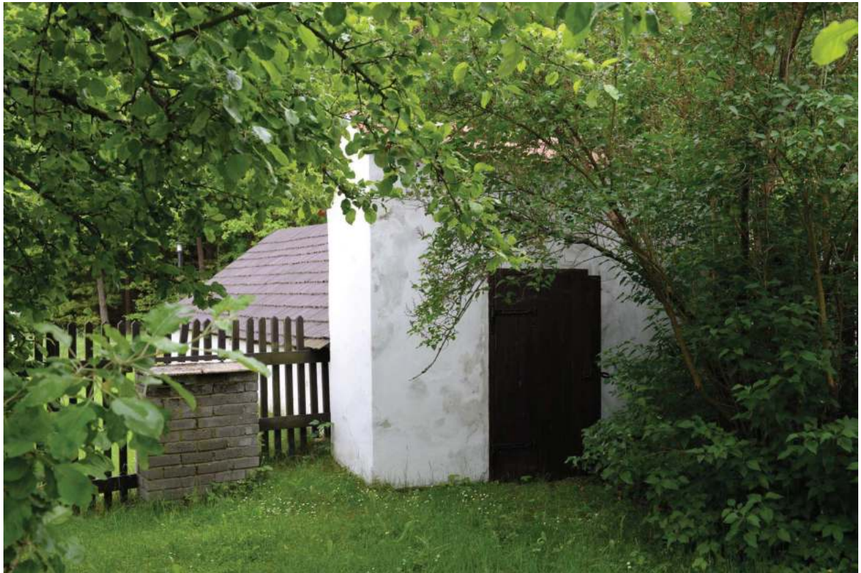
51. východní křídlo, sklep na jižní straně zaniklé stodoly, pohled od západu (ze dvora)
