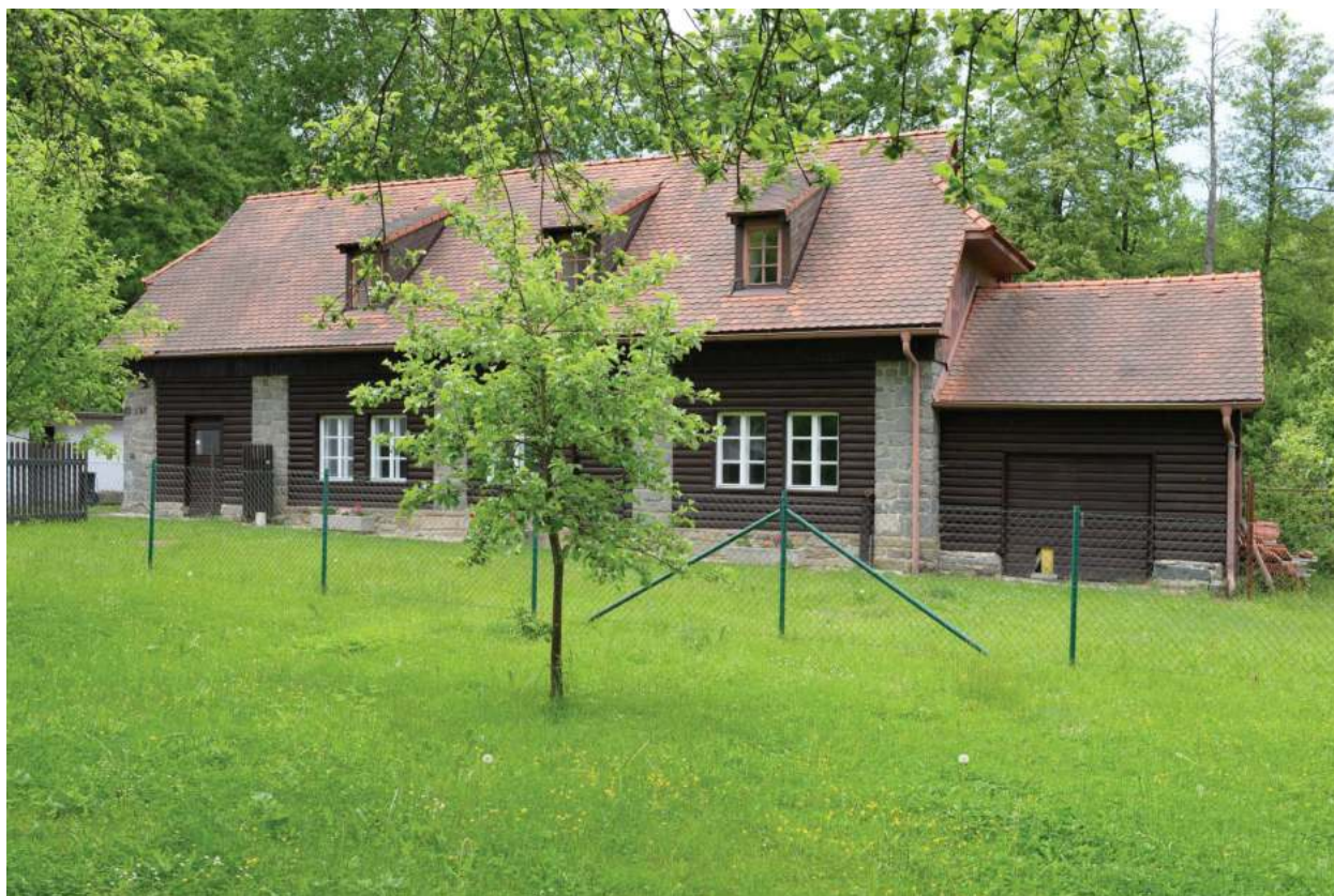
49. severní křídlo (novodobá provozní budova), celkový pohled od jihu
