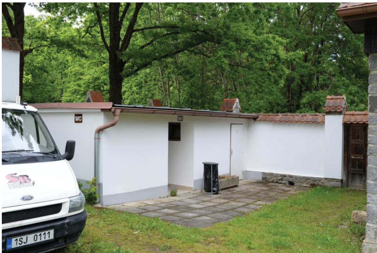
47. severozápadní kout dvora (vestavba WC)
