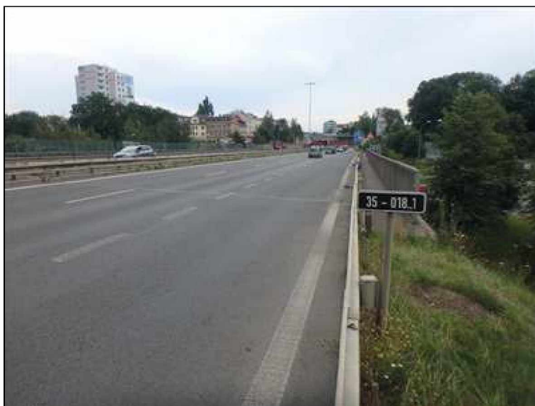
Pohled na most ve směru staničení.
