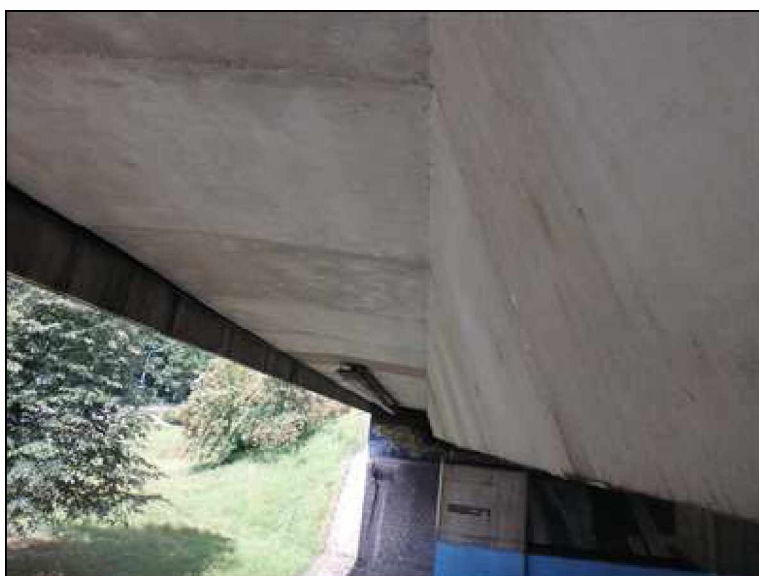
Podhled pravé konzoly.
