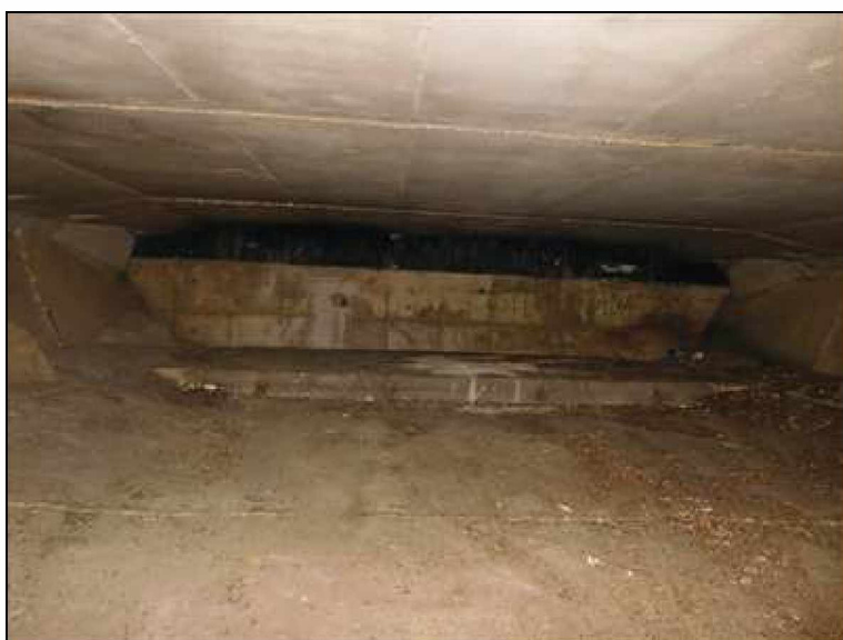
Pohled na nadpodporový příčník nad opěrou 1.
