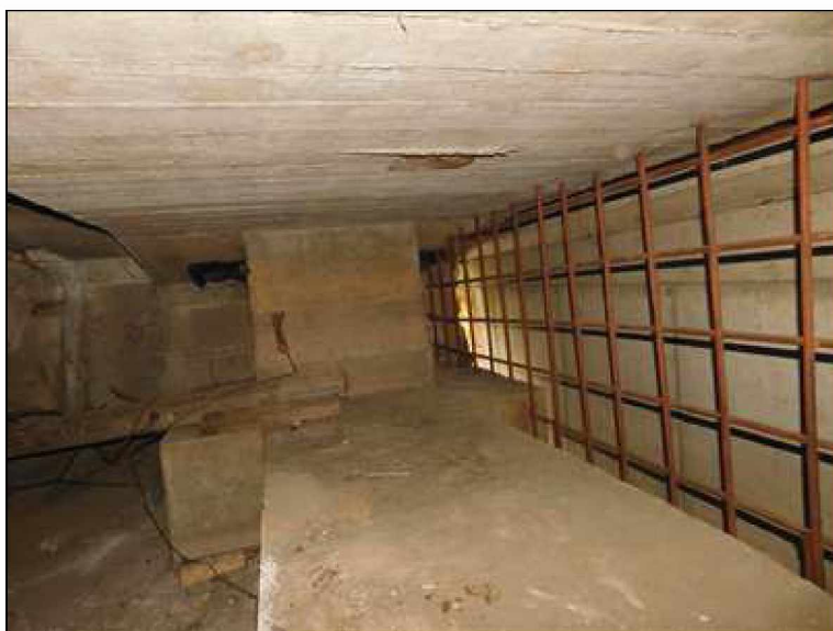
Nadpodporový příčník nad opěrou - pohled z dutiny nosné konstrukce).
