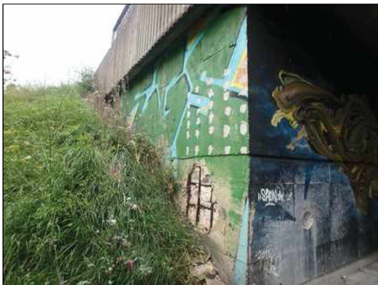
Pravé křídlo opěry 1.
