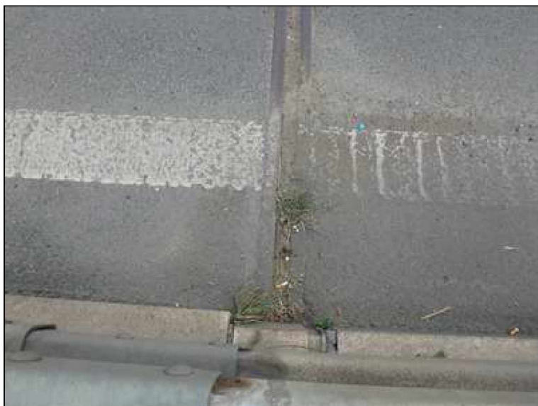
Nečistoty a uchycená vegetace v mostním závěru.
