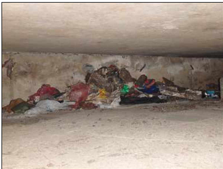
Nečistoty na úložném prahu.
