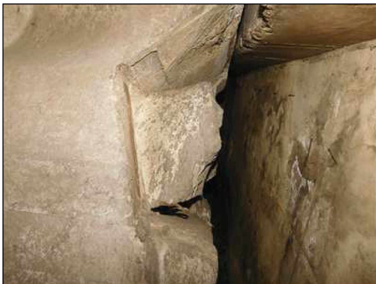
Kotevní blok předpinací výztuže na konci nosné konstrukce.
