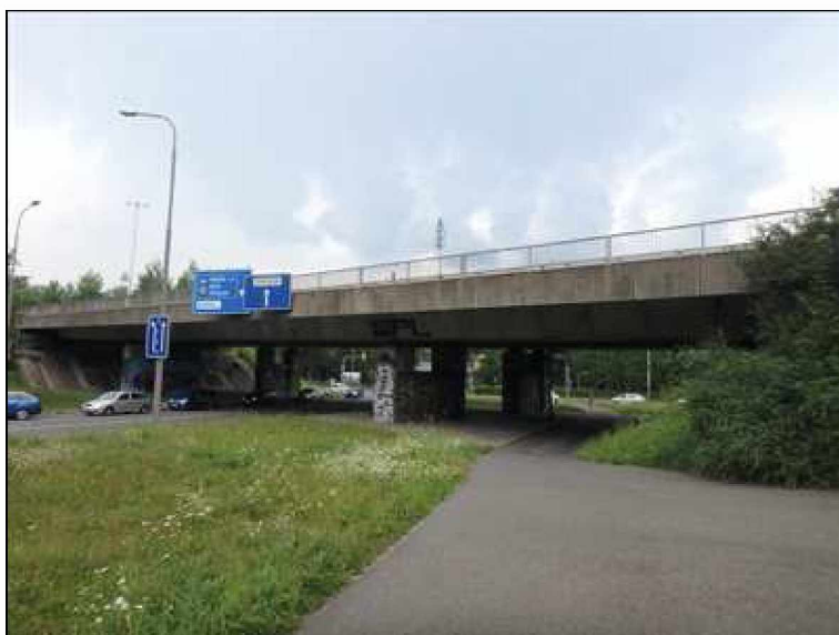
Pohled na most zprava.
