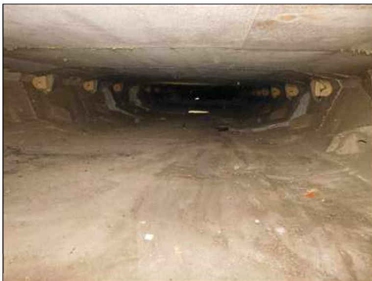
Pohled do dutiny nosné konstrukce od opěry 1.
