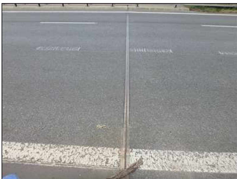
Mostní závěr nad opěrou 4.
