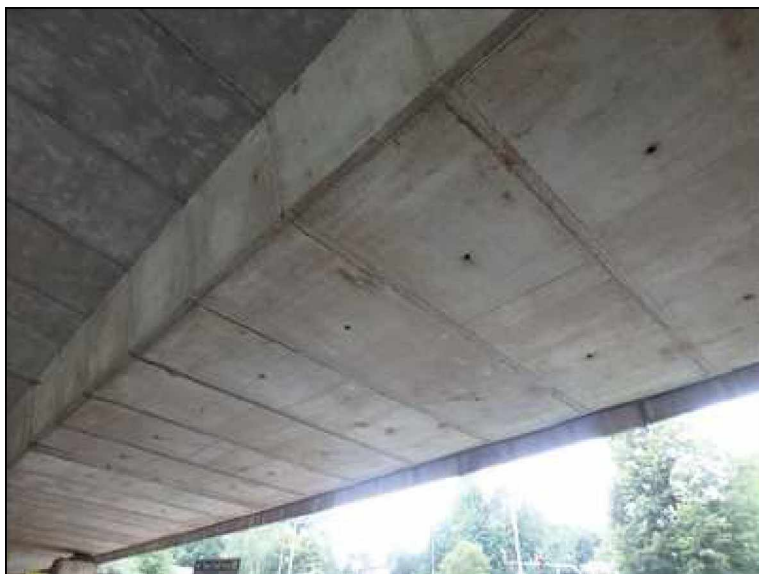
Podhled nosné konstrukce v poli 2.
