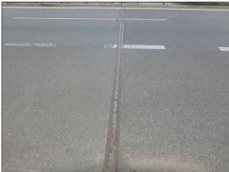
Pohled na mostní závěr nad opěrou 4.
