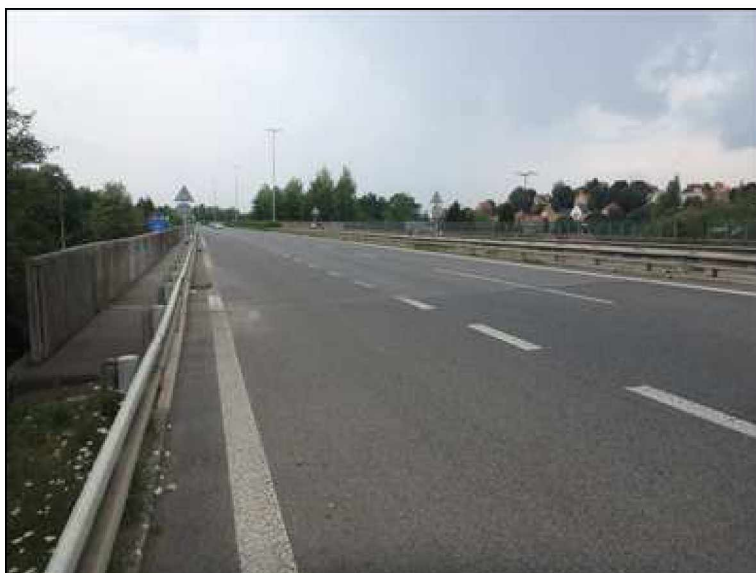
Pohled na most proti směru staničení.
