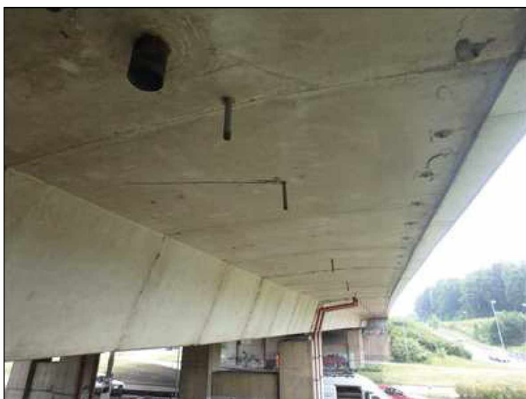
Podhled pravé konzoly.
