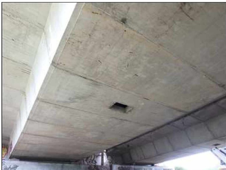
Podhled nosné konstrukce v poli 1.
