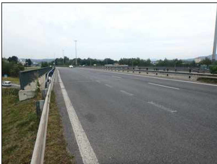
Pohled na most proti směru staničení.
