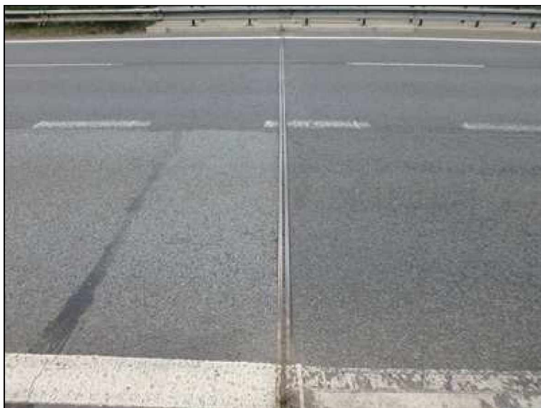
Mostní závěr nad opěrou 1.
