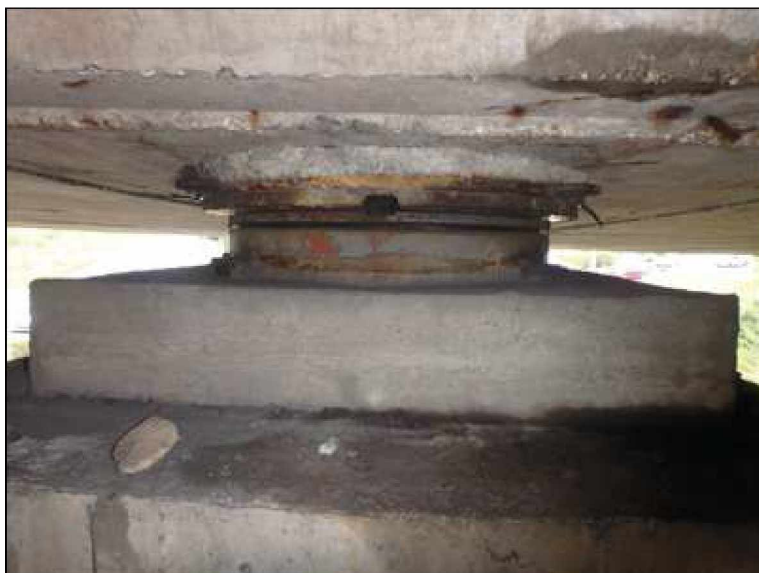
Levé ložisko na pilíři 2.
