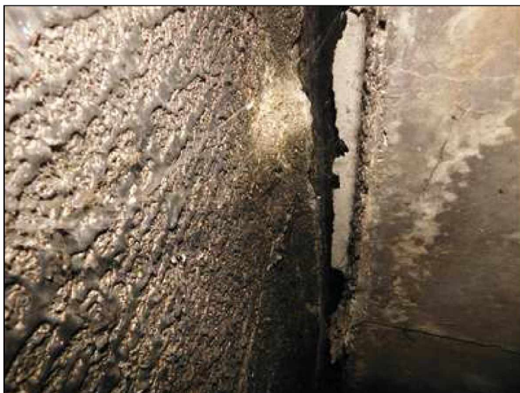
Podhled mostního závěru nad opěrou 4.
