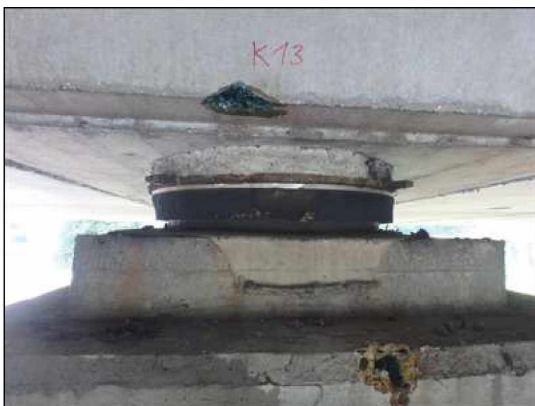
Levé ložisko na pilíři 2.
