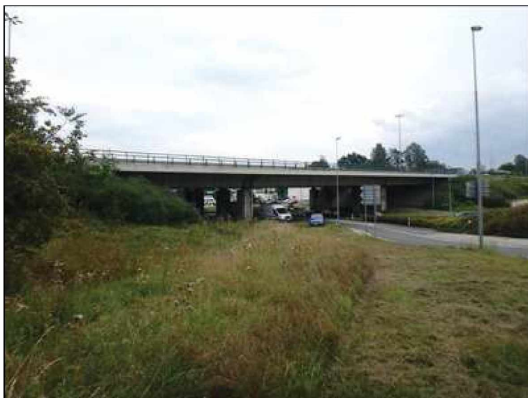
Pohled na most zprava.
