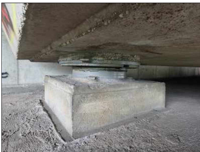
Pravé ložisko na opěře 1.
