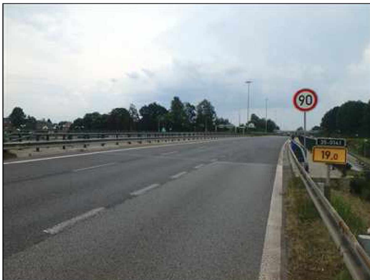
Pohled na most ve směru staničení.
