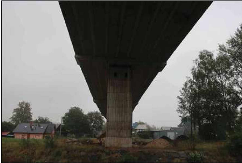
pohled na pilíř 7
