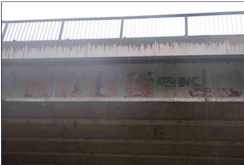
vyznačení jména autora konstrukce na vnějším boku krajního nosníku
