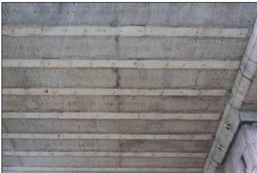
pohled na příčné spáry mezi korálky nosníků
