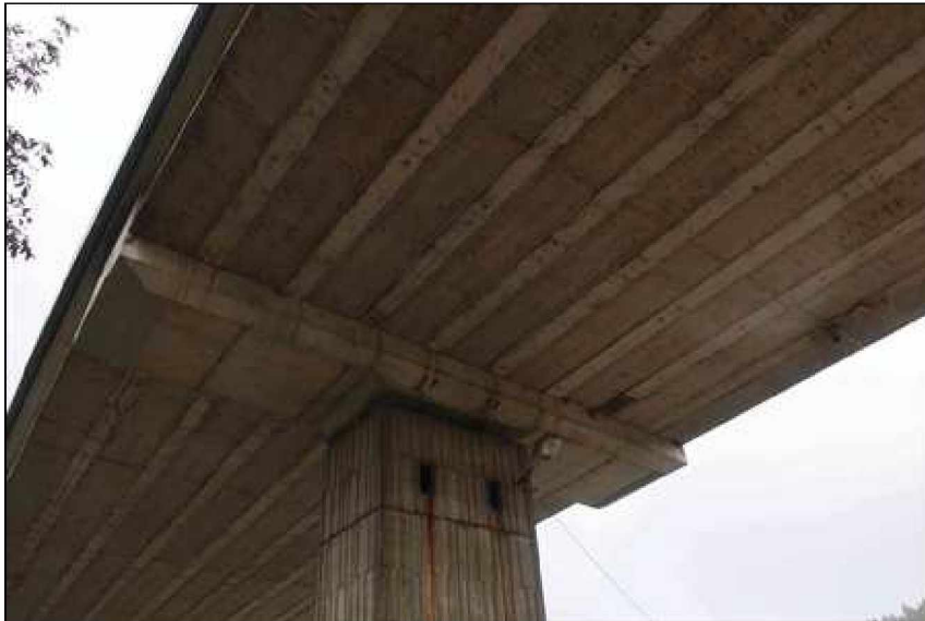
nad skladištěm je na líci pilíře umístěno osvětlení
