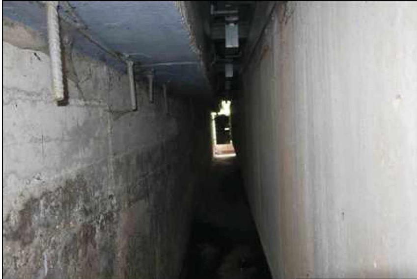
podhled MZ nad O1
