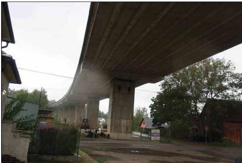
podhled NK od P11 proti směru staničení
