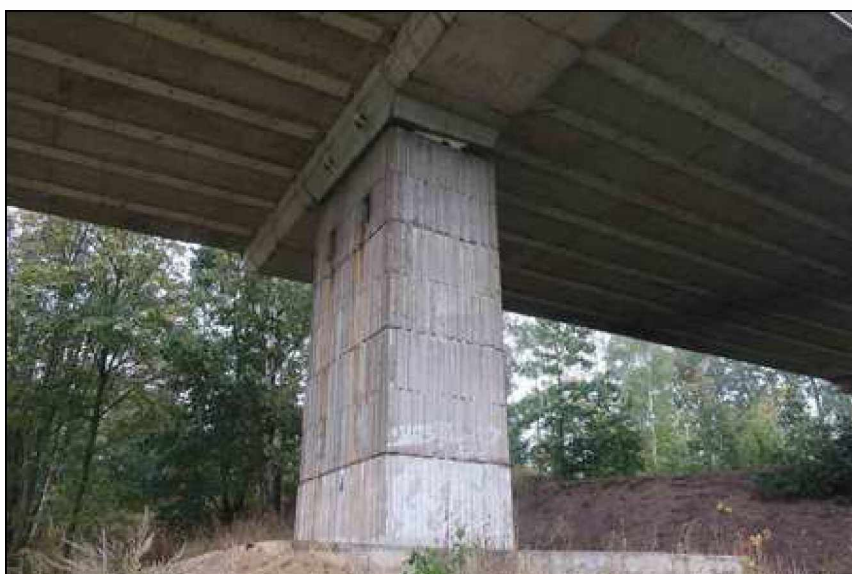
pohled na pilíř 3
