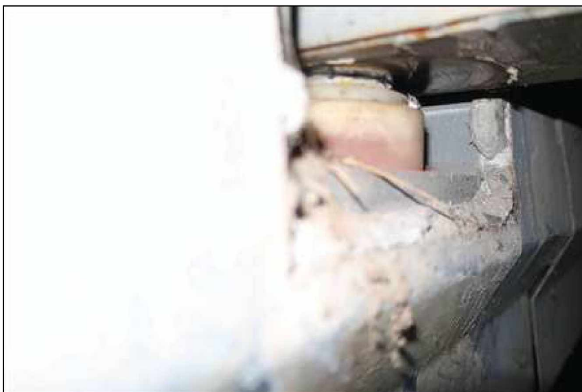
ložisko MZ nad O13
