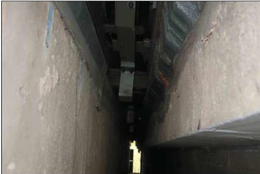
podhled MZ nad O13
