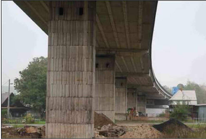
pohled na most ve směru staničení od pilíře 6
