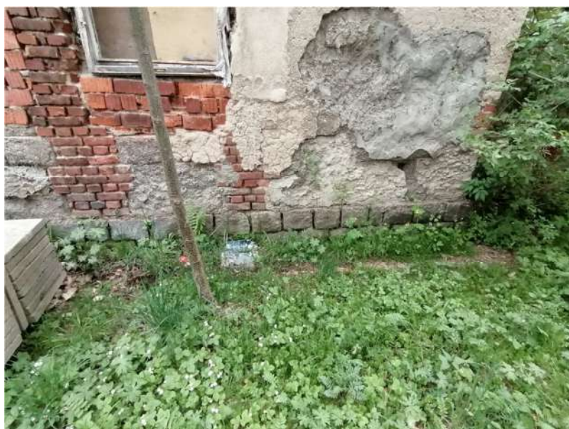
Obr.10: Kamenné zdivo na maltu
