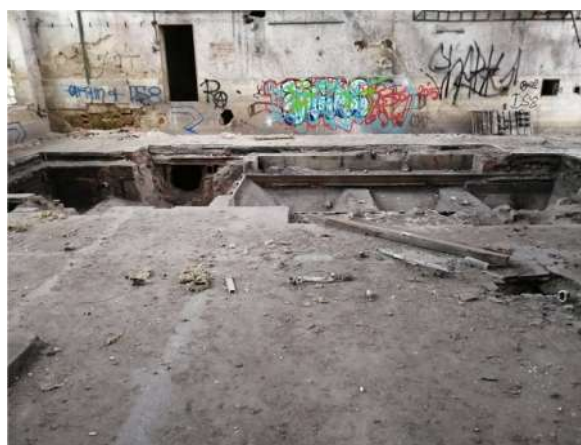
Obr.29: Pohled na stropní konstrukci v části B
