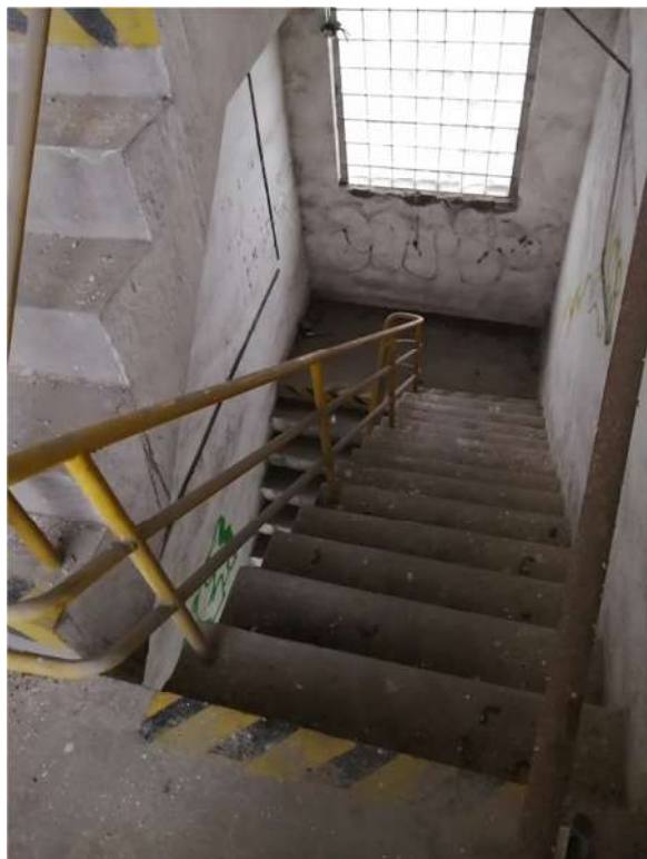
Obr.40: Pohled na schodiště
