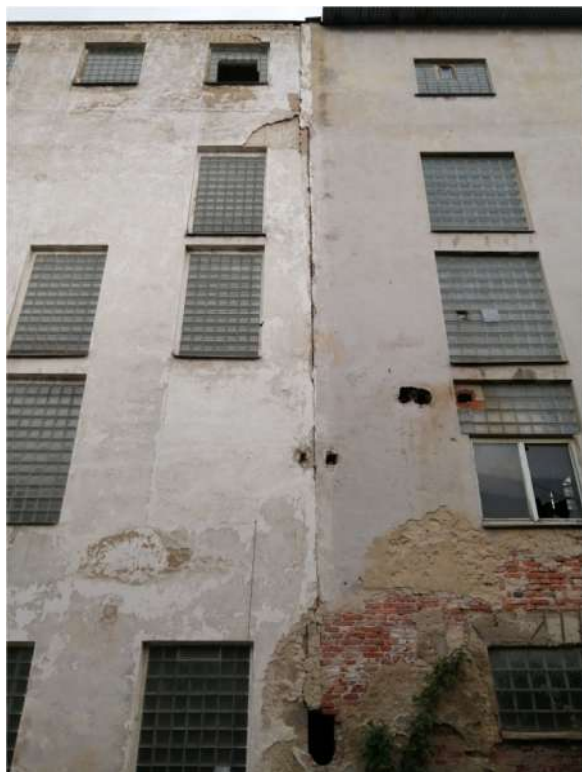
Obr.14: Dilatace mezi částmi A1 a B
