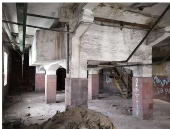
Obr.25: Pohled na stropní konstrukci v části A1
