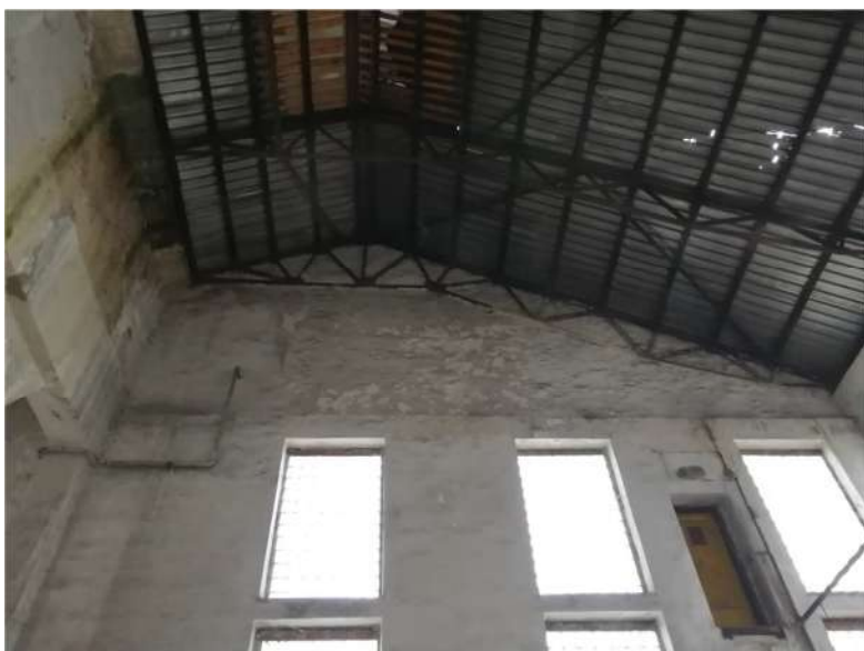
Obr.42: Pohled na střešní konstrukci v části A1
