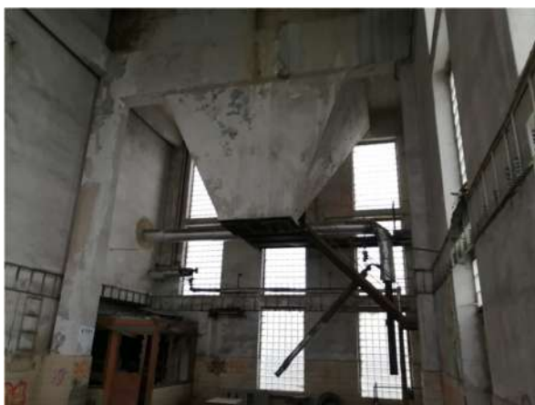
Obr.26: Pohled na stropní konstrukci v části A1
