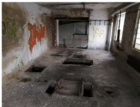
Obr.27: Pohled na stropní konstrukci v části A1
