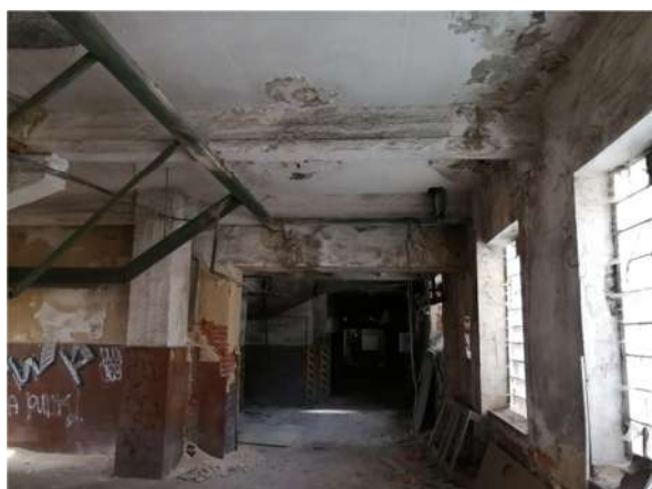
Obr.30: Pohled na stropní konstrukci v části A1
