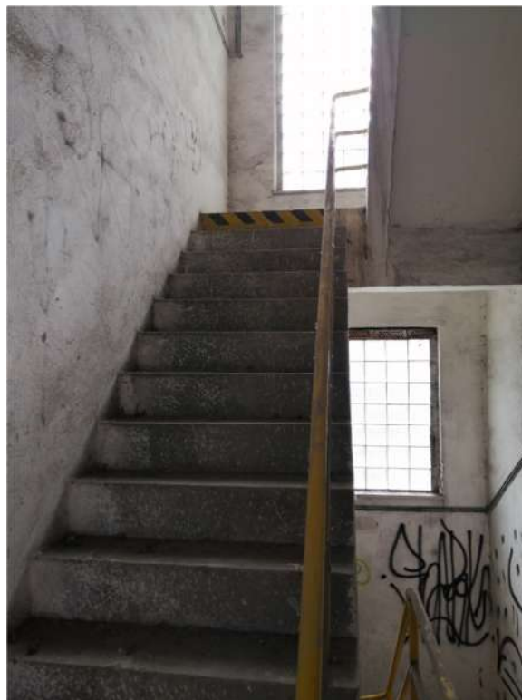
Obr.41: Pohled na schodiště
