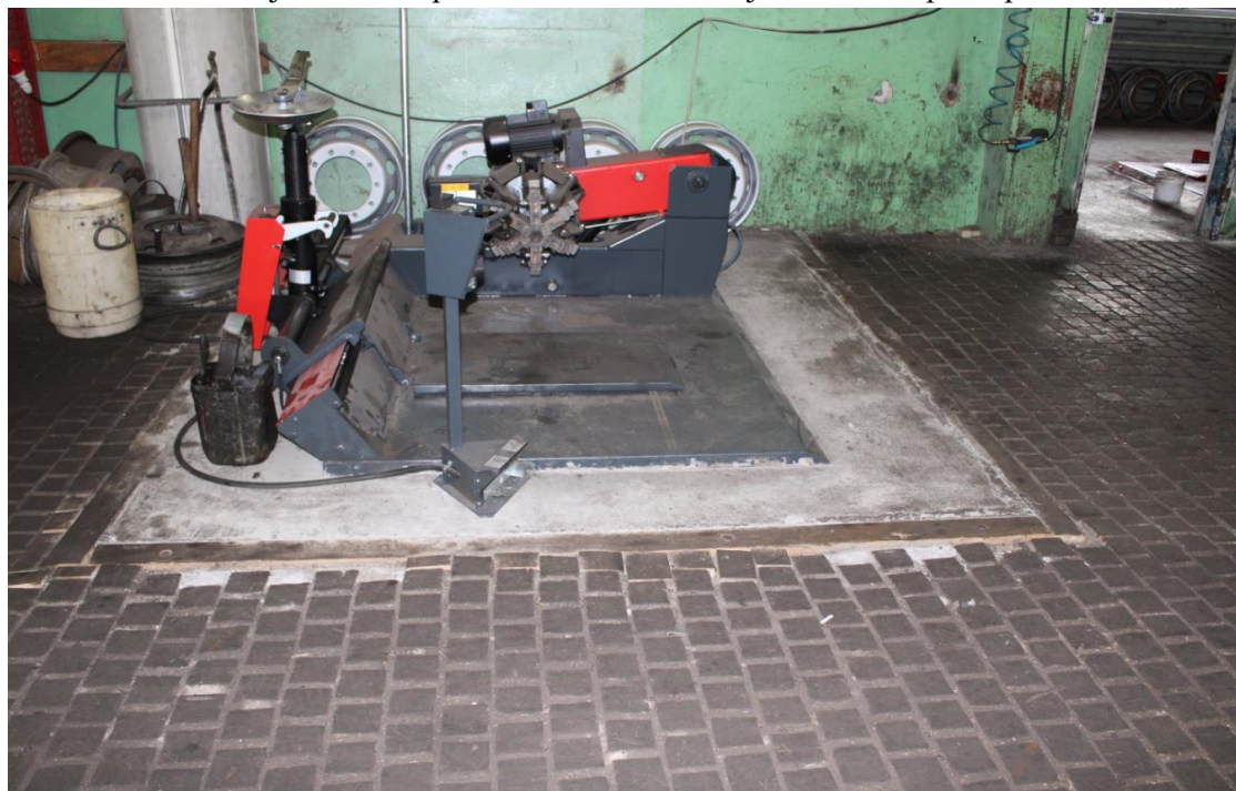
Obr. 1 stávající dřevěná podlaha z kostek a stávající betonová patka pod zařízením
