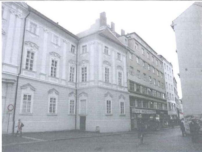
Pohled na dotčenou část budovy na ulici Běhounská
