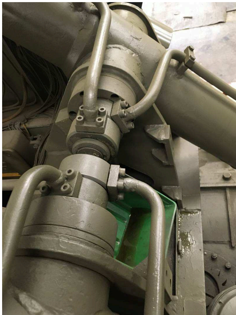
Foto č. 7 - Přetěsnění převodového rozvodu na válci výložníku.
