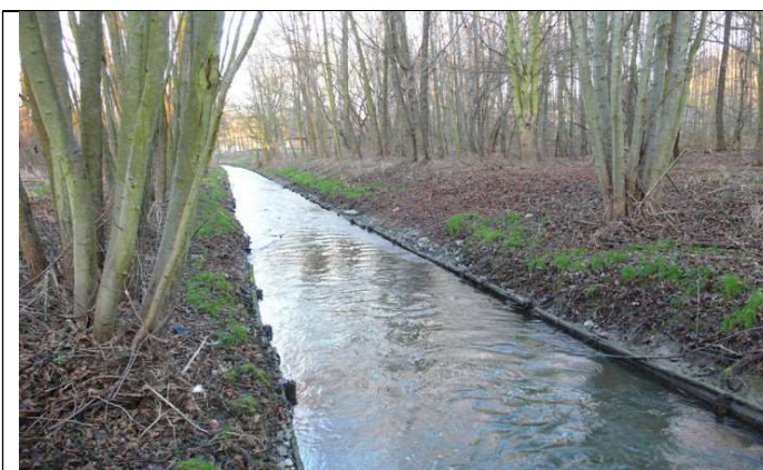
Obr. č. 5 Skoro tři kilometry Zákolanského potoka mezi Otovicemi a Minicemi, resp. okrajem Kralup, jsou takto technicky upraveny. Potok tu prochází ponejvíce údolním hájem, taková to technická úprava je tedy nadbytečná. Hluboké, přímé a hladké koryto je nejen ekologicky znehodnocené, ale také může významně zrychlovat postup případných povodní do Kralup. Revitalizace tohoto úseku je vysloveně vhodná. Mimo jiné by mohla významně podpořit procesy samočištění vody (důležité mj. vzhledem k přetrvávajícím problémům Dřetovického potoka) a přispět ke zpomalování postupu povodní do Kralup nad Vltavou.
