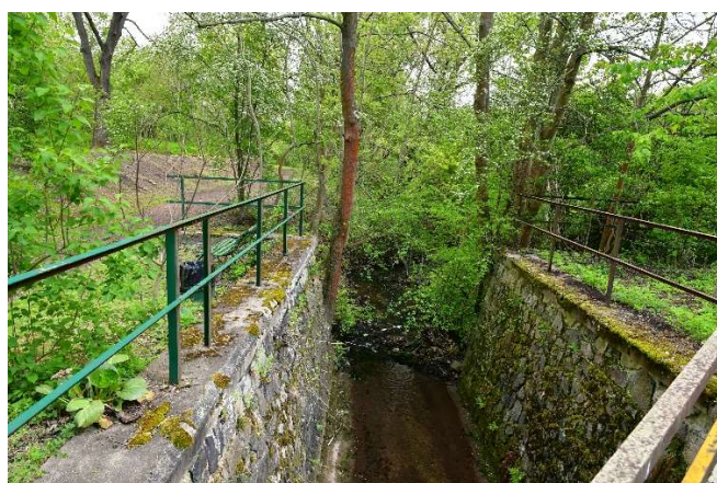
Obr 20 - Knovízský potok ve zdech pod železničním viaduktem v Podlešíně
