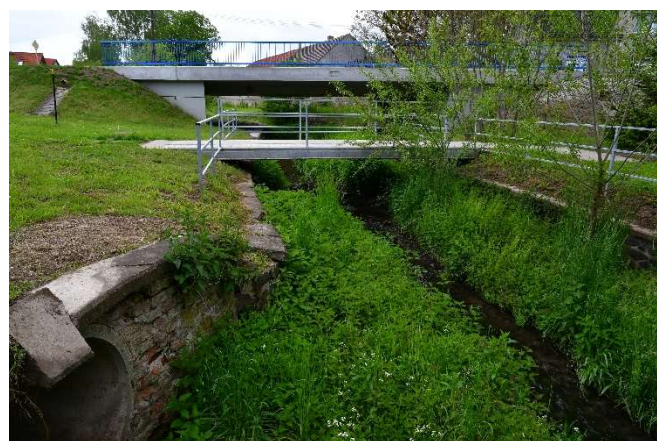
Obr 19 - Knovíz – nový most a komplikovaná infrastruktura v urbanizované části obce
