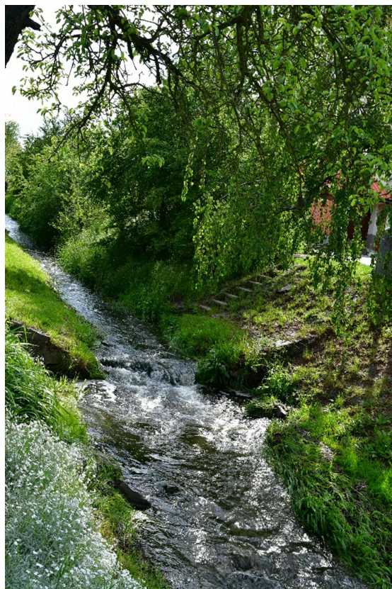
Obr 47 - Zákolanský potok – Kralupy nad Vltavou – přímá trasa toku v úpravě s lichoběžníkovým profilem s drobnými objekty a doprovodnou vegetací – doplněná PP hrází
