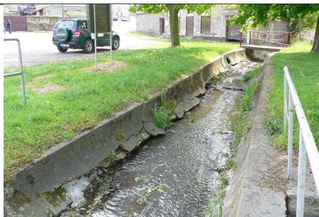
Obr. č. 2 V obcích v horním povodí Zákolanského potoka se vyskytují zajímavé ukázky z oboru intravilánových technických úprav koryt. V posledních letech jsou některé z těchto obcí častěji vyplavovány velkými vodami, což možná bude podnětem k úvahám o nových řešeních, v nichž by se mohly uplatnit také přístupy intravilánových revitalizací.
