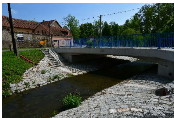
Obr 32 - Zákolanský potok – nedávno zrekonstruovaný most v Okoří s kamennou úpravou v okolí mostu
