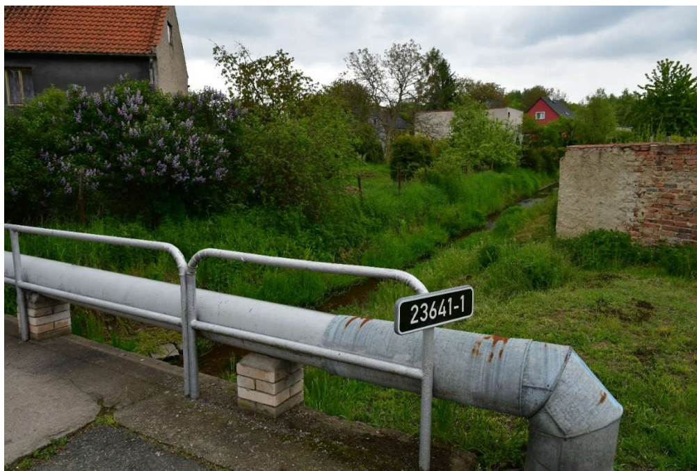
Obr 14 - Technické objekty v horní části povodí Knovízského potoka
