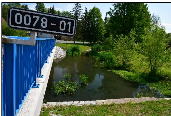
Obr 29 - Nově zrekonstruovaný most v Čičovicích se zachováním nevhodného vedení trasy toku
