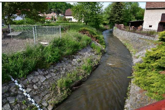
Obr 43 -Upravená část Zákolanského potoka v Otovicích s vodočtem v lichoběžníkovém profilu – foto z mostku po vodě
