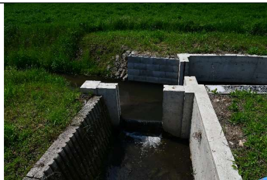
Obr 13 rozdělovací objekt před soutokem se Svinařovickým potokem
