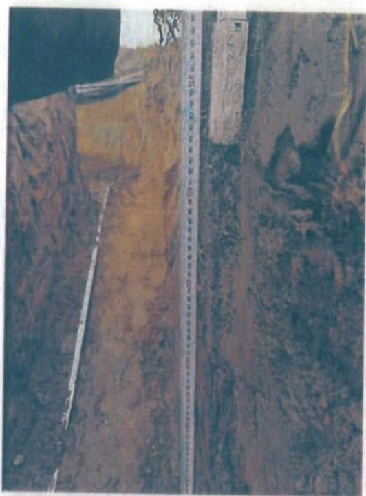
Výkop základů – křídlo SEVER
