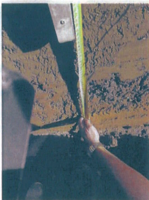
Výkop základů – křídlo JIH
