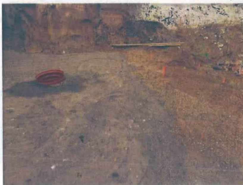
Zřízení čerpací šachty
