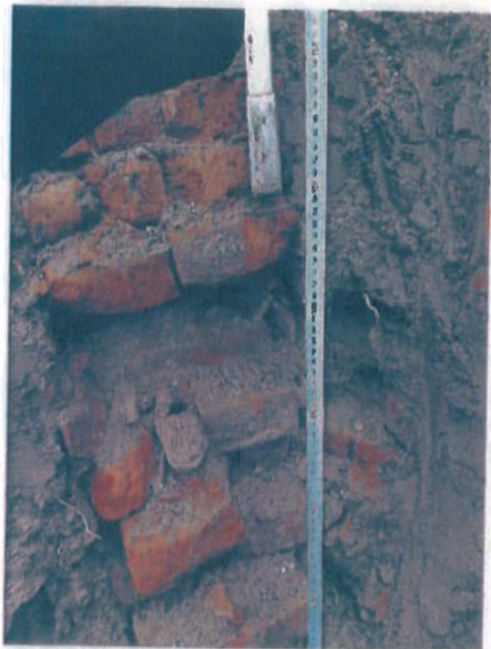
Výkop základů – křídlo SEVER
