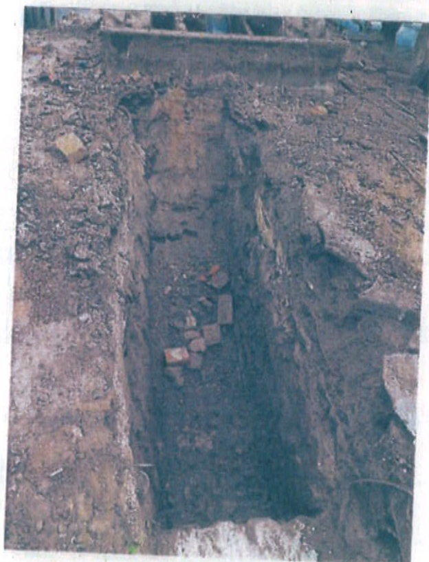
16.11.2020 Výkop základů SEVER
