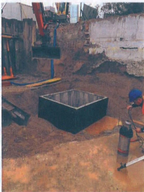
Prefabrikovaná šachta pro budoucí ČS1
