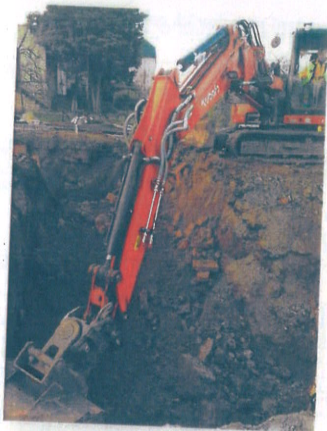
3.11.2020 výkop základů křídlo SEVER (výkop zbytků starých základových konstrukcí)
