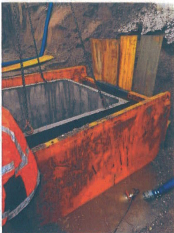
Osazení prefabrikované jímky pod hladinu spodní vody pro budoucí ČS1
