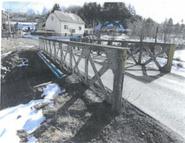
Pohled na most ve východním směru.
