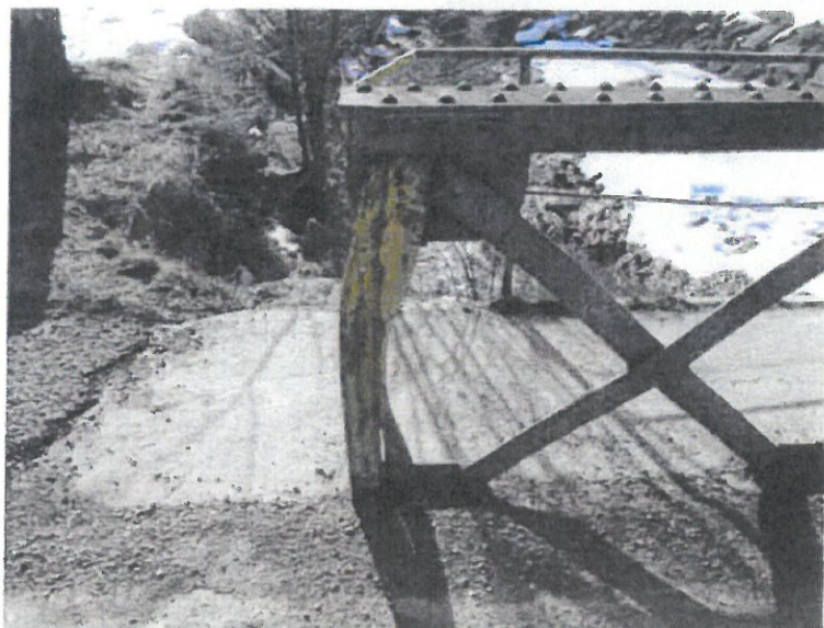
Degradovaná nadpodporová svislice hlavního příhradového nad pravoběžní opěrou.
