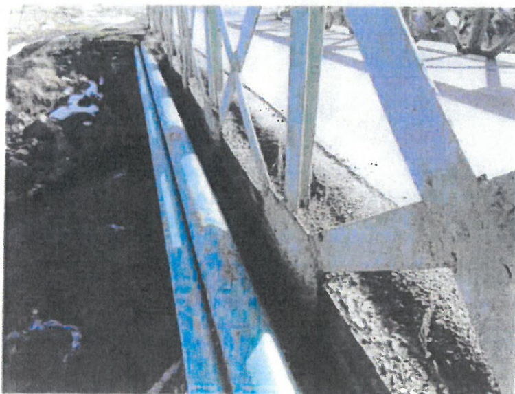
Vegetace a inertní materiál uchycená na dolním pásu příhradového nosníku.
