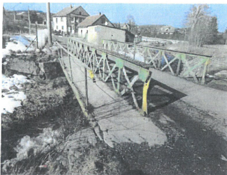
Celkový pohled na most ze strany chodníku.
