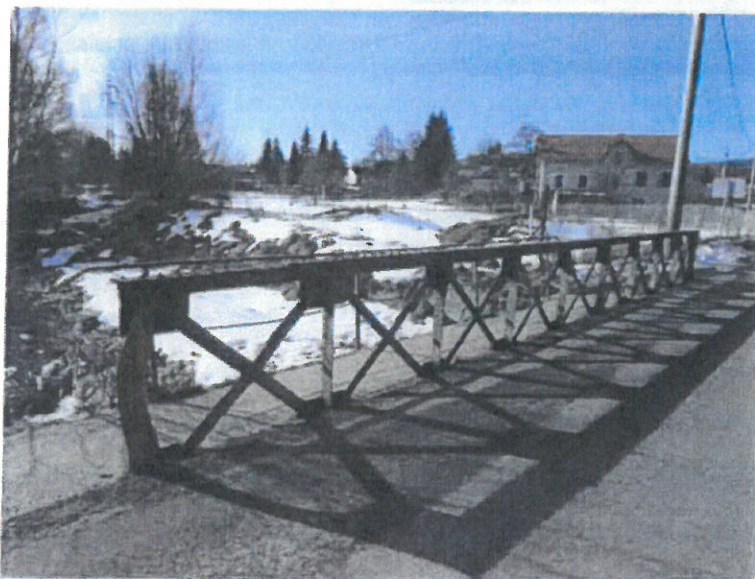
Hlavní příhradový nosník na protivodní straně mostu.
