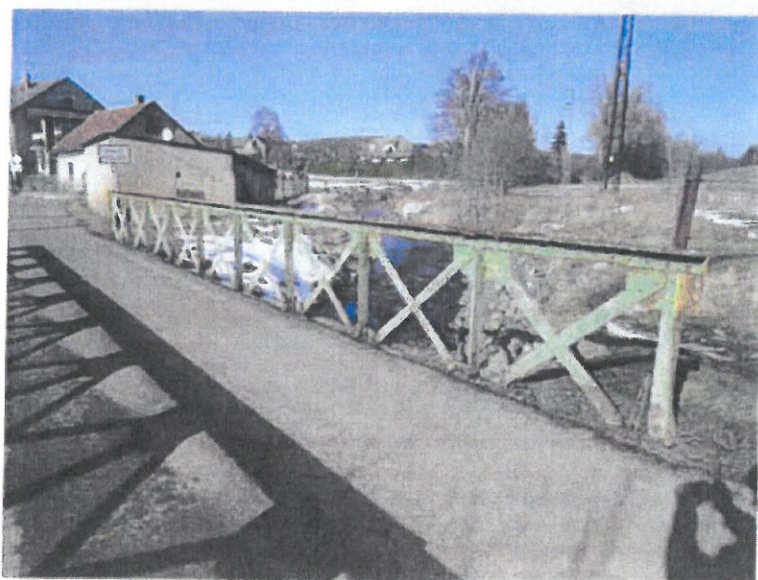
Hlavní příhradový nosník na povodní straně mostu.
