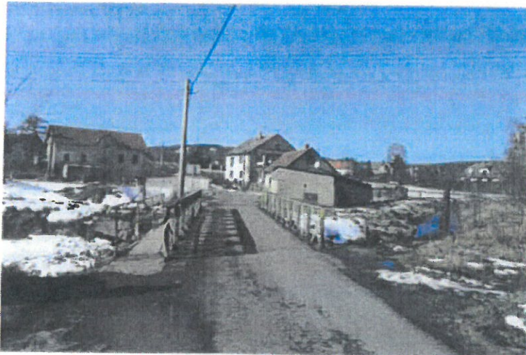
Celkový pohled na most v západním směru.
