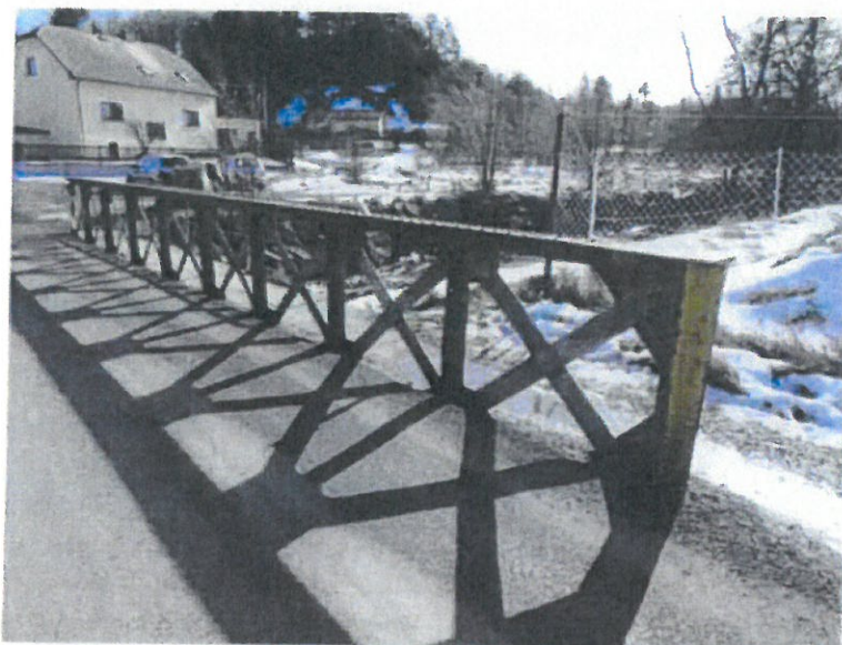
Přhradový nosník na protivodní straně mostu.
