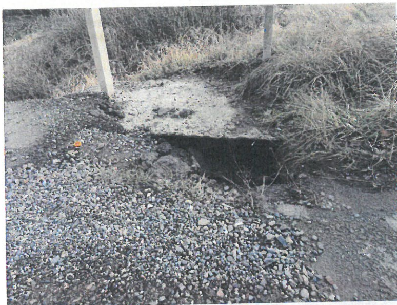
Detail kaverny v jihozápadním sektoru mostu.
