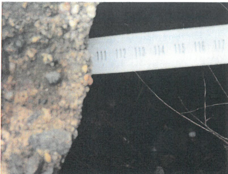
Do kaverny v jihozápadním sektoru bylo možné vysunout metr do hloubky 1,1 m.
