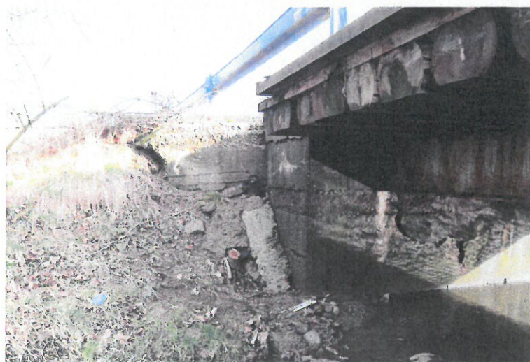
Křídlo pravobřežní opěry.
