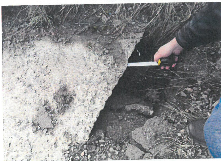
Do kaverny v jihozápadním sektoru bylo možné vysunout metr do hloubky 1,1 m.
