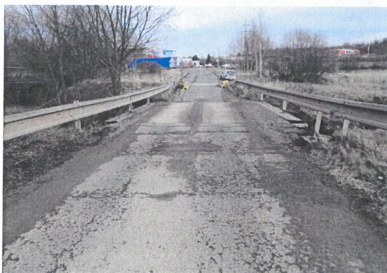
Pohled na most ve východním směru.
