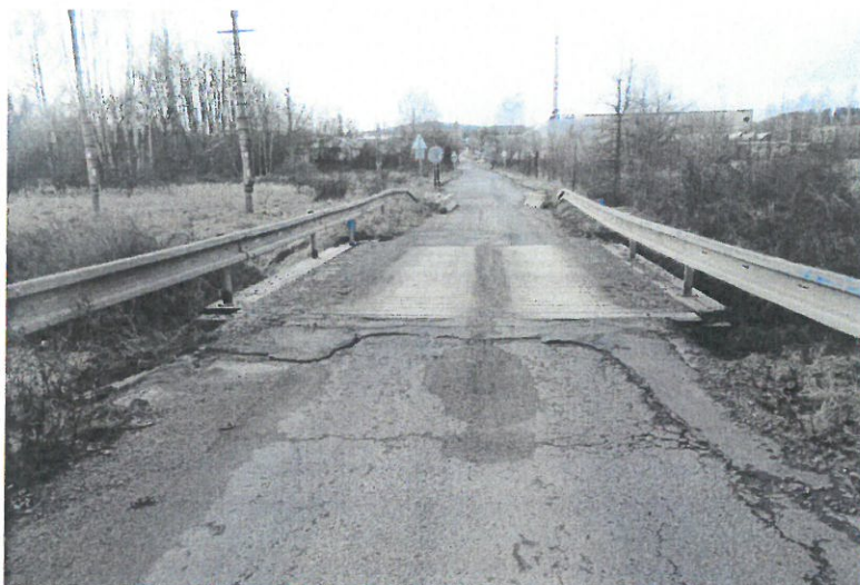
Pohled na most v západním směru.
