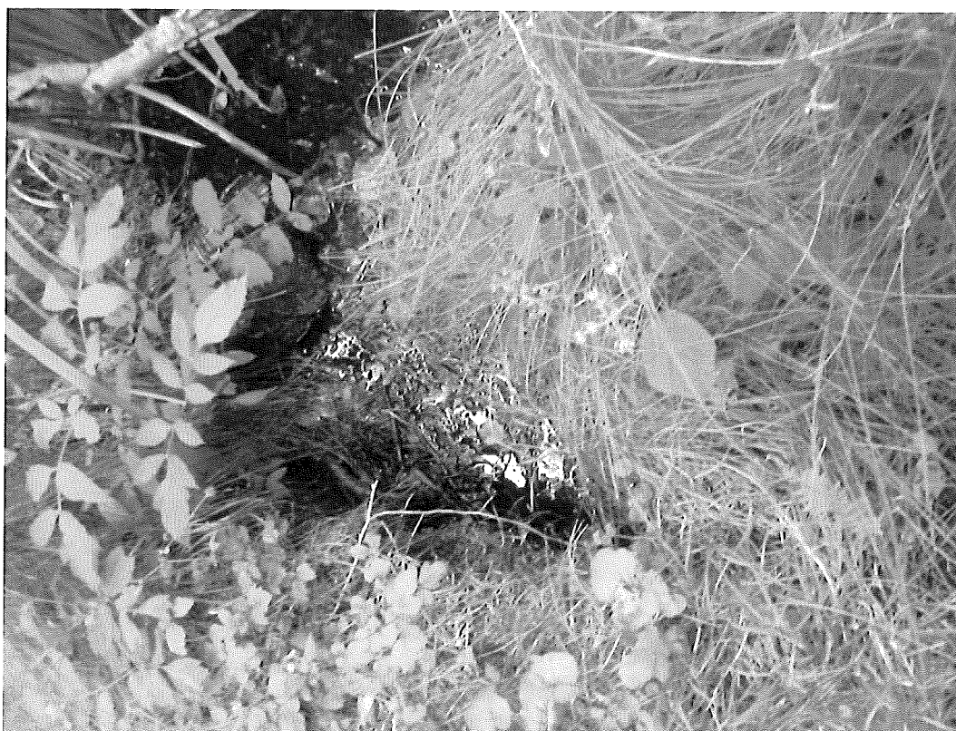
Obrázek 6: Vtok do výtokového potrubí
