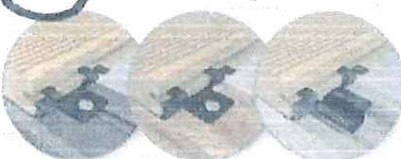
Montáž pomocí systému spon
