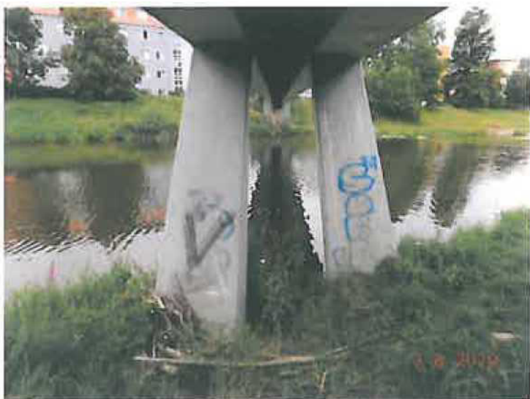
Pohled na mezilehlou (PB) podpěru a NK.
