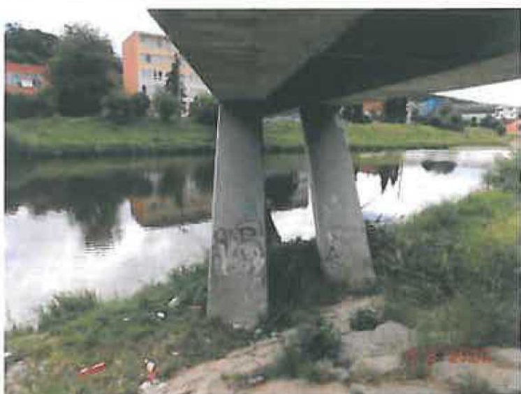
Pohled na mezilehlou (LB) podpěru a NK
