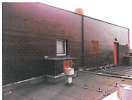
Exteriér střecha strojovny VZT
