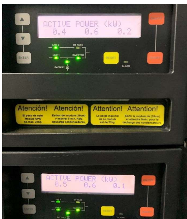
Obrázek 5-5: Displej modulů UPS
