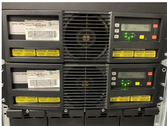
Obrázek 5-4: Modulární zdroj ABB
