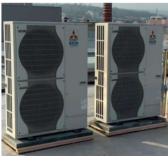
Obrázek 5-3: Kondenzační jednotky
