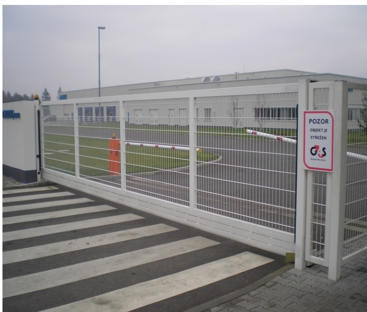
Foto č. 2 - možné řešení samonosné posuvné brány:
