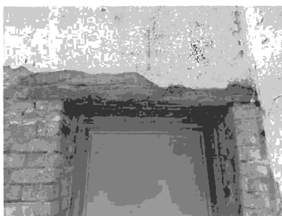
FOTO č.12 - Překlady očištěny a natřeny
