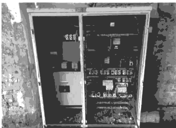
FOTO č.1 - Elektromontáže - zrevidování stav el. rozvodů a rozvaděče
