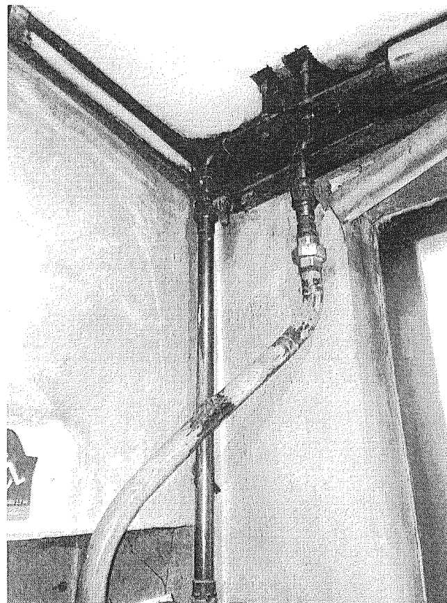
Napojení na otopnou soustavu
