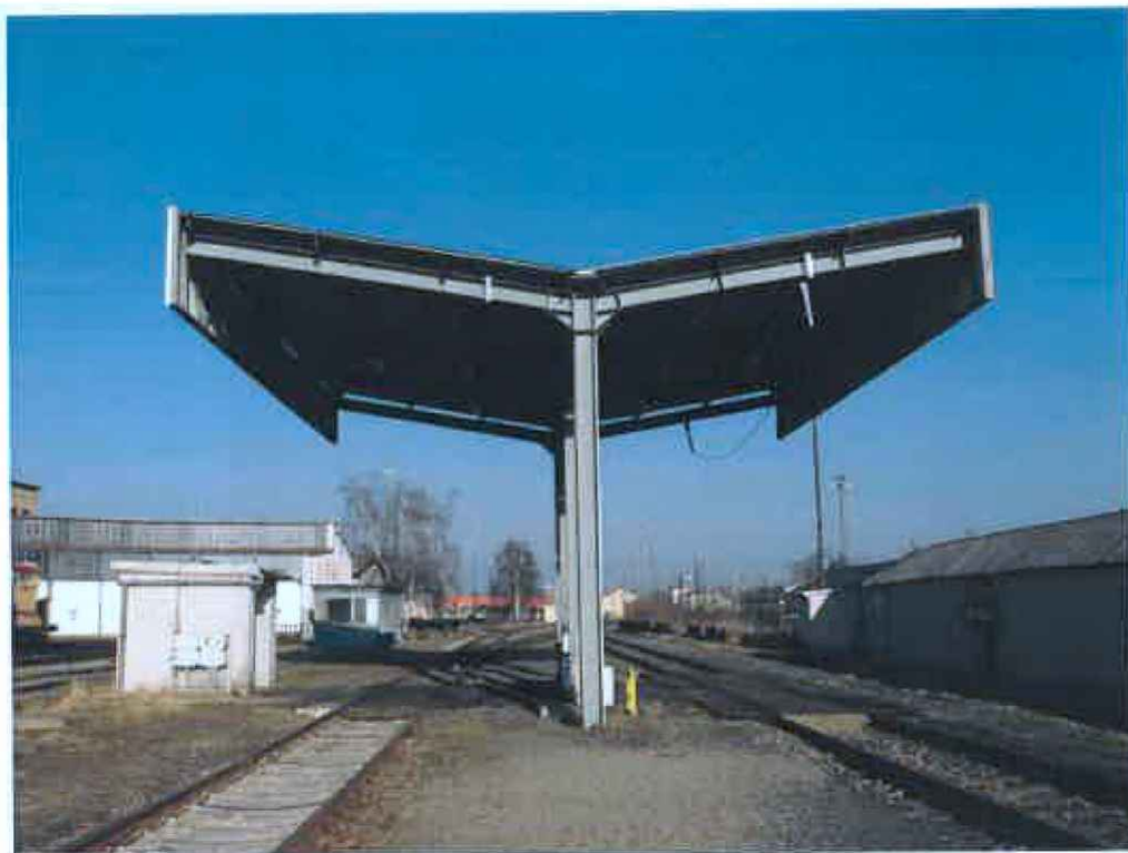
(vlevo od přístřešku)
