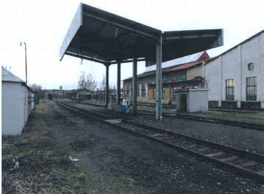
Pozemek p.č. 3793/173 - část: přístřešek čerpací stanice, technologie
