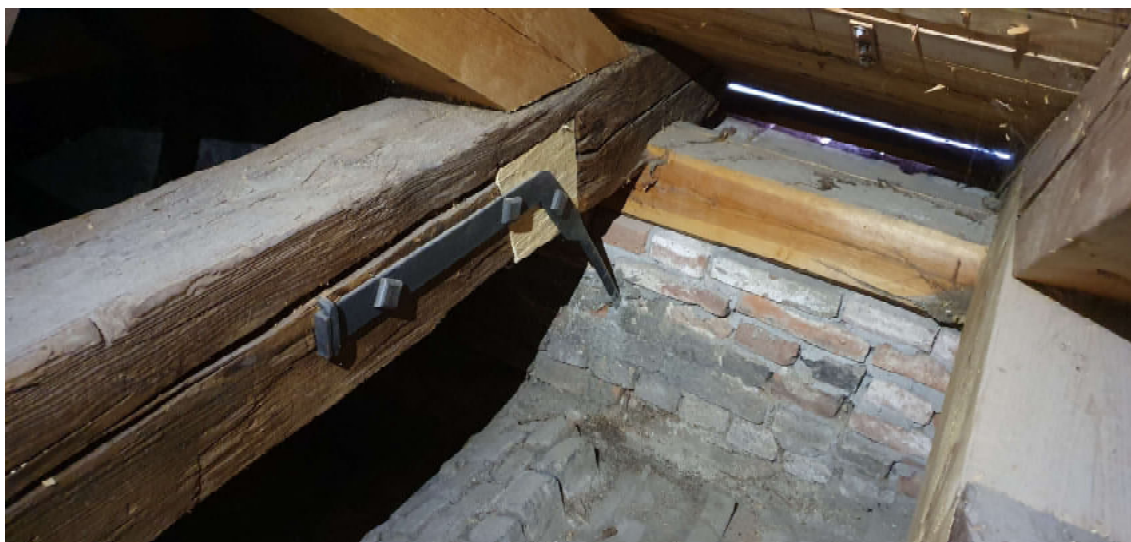
Obrázek 1: Podkroví 2, pokladnice: Skutečné provedení zajištění obvodového zdiva
