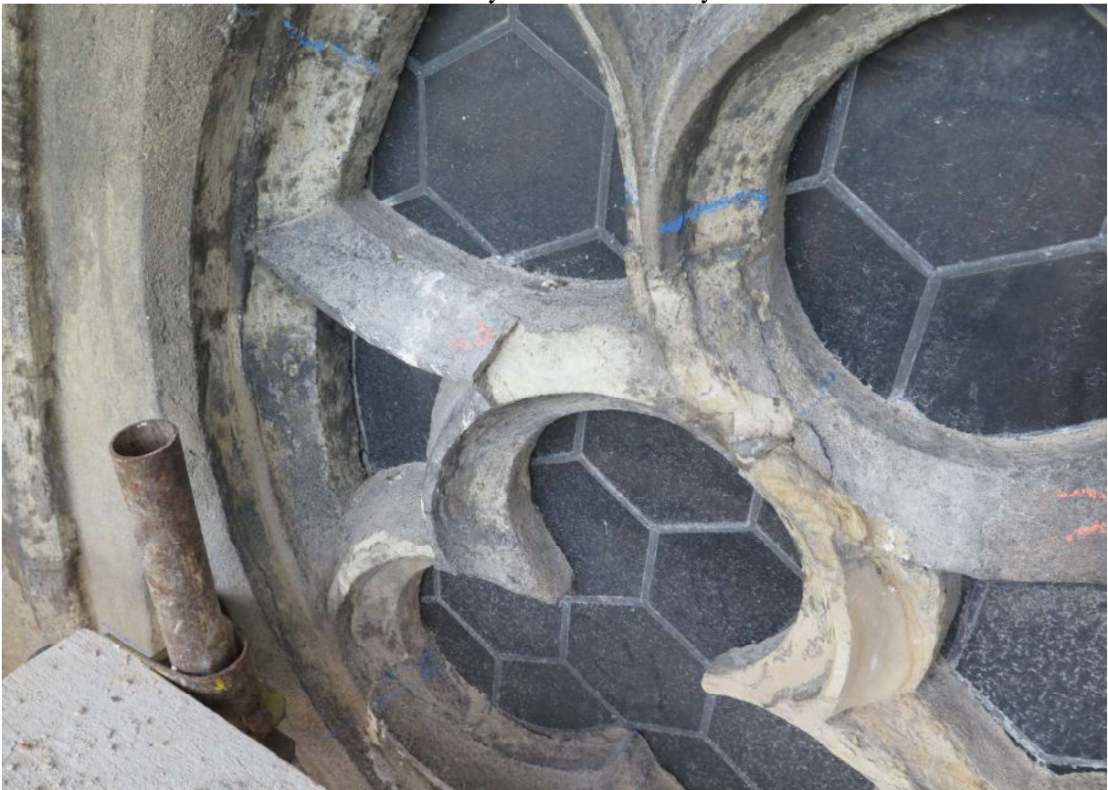
Pohled na střední část kružby tvarovanou tmely z tvrdého materiálu
