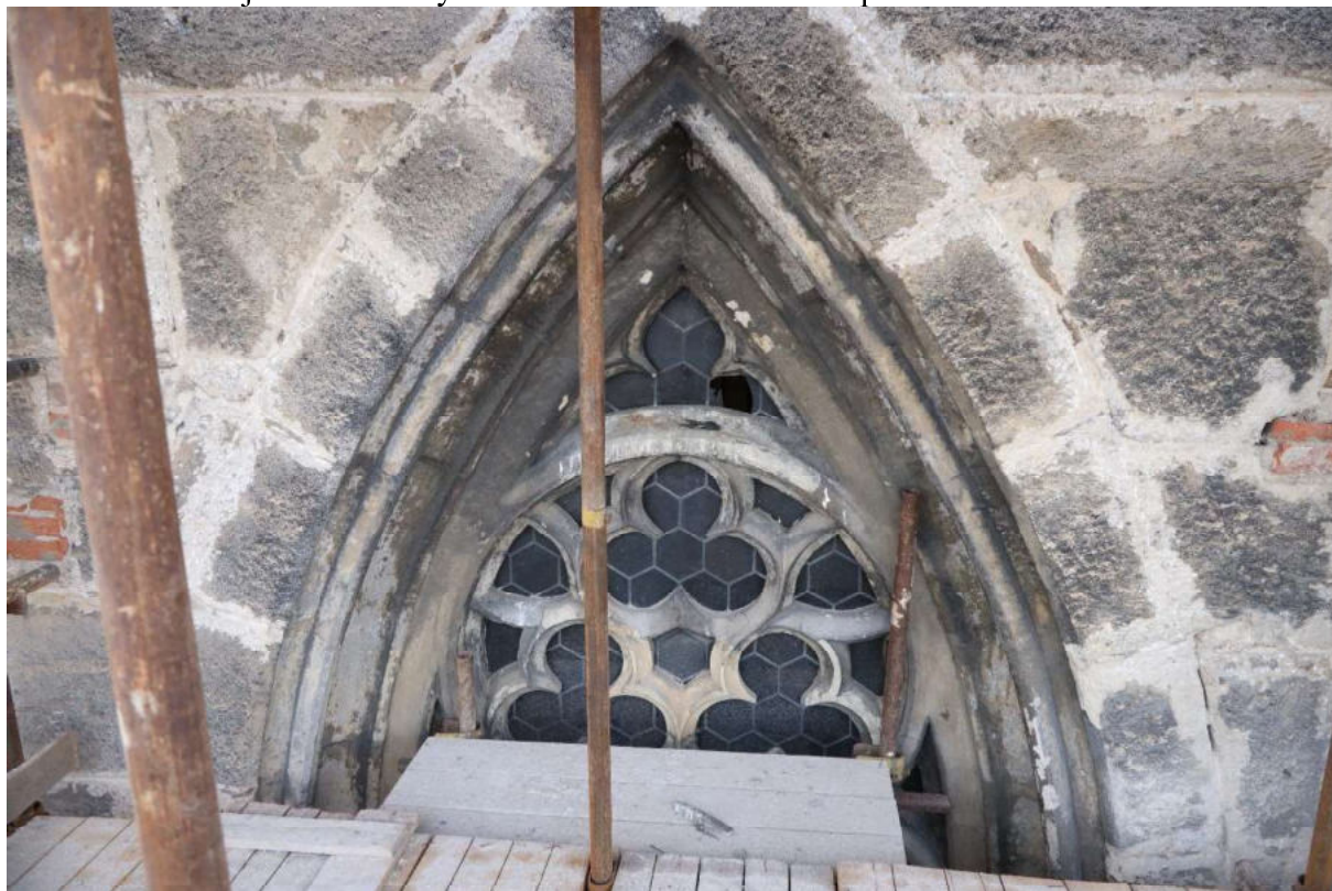
Pohled na havarijní stav kružby vitrážového ostění VIT12 – před zhotovením sond
