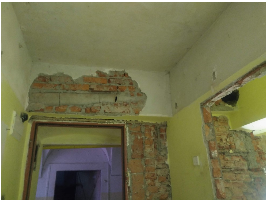
Foto č. 5 – kouřovody
