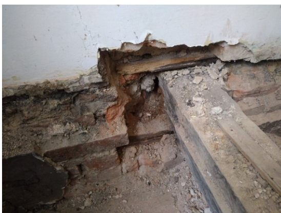
Foto č. 2 – pozednice ve zdivu
