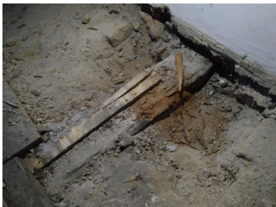
Foto č. 3 – podlahové trámy nad klenbou
