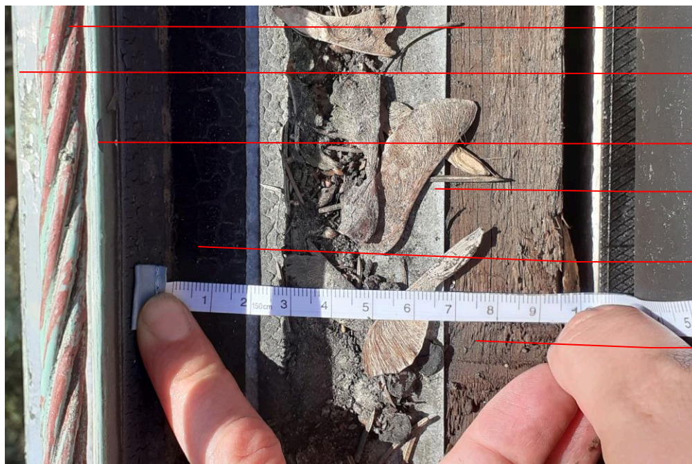
POHLED SHORA NA DŘEVĚNÝ PODKLADNÍ PROFIL OPLECHOVÁNÍ - PO ODKRYTÍ ŽIVIČ. PÁSU
