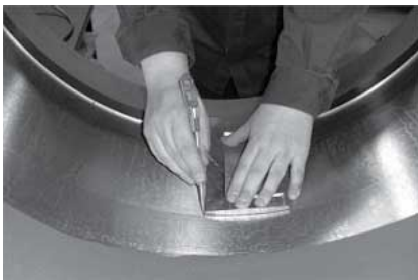
Obrázek 38: Vyznačení přímky pro vrtání
