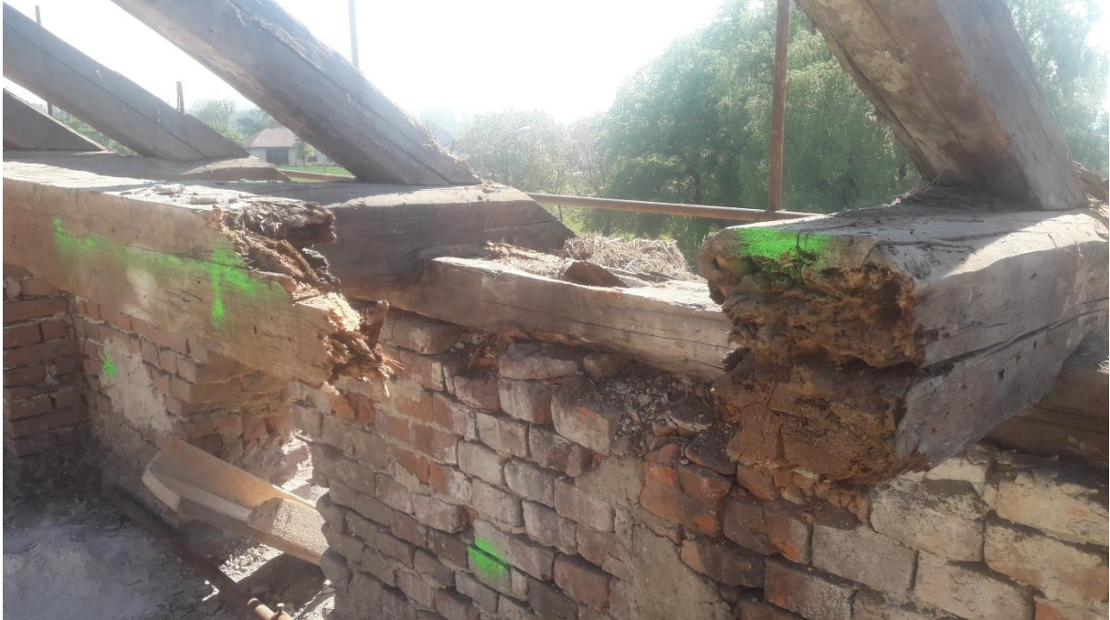
Stav krovu (objekt C)
