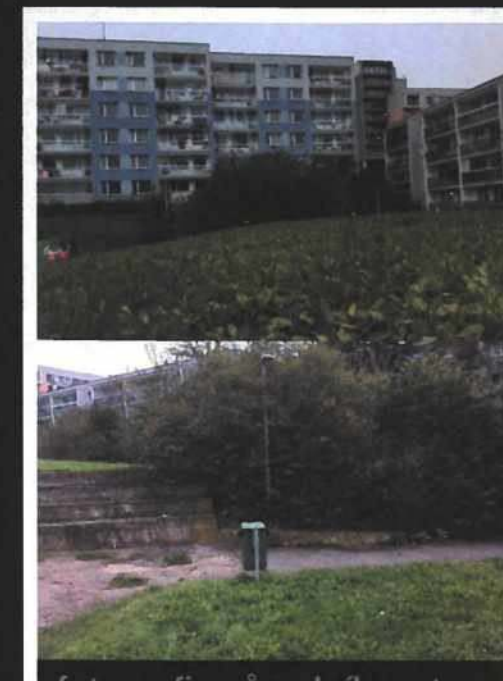
fotografie původního stavu
