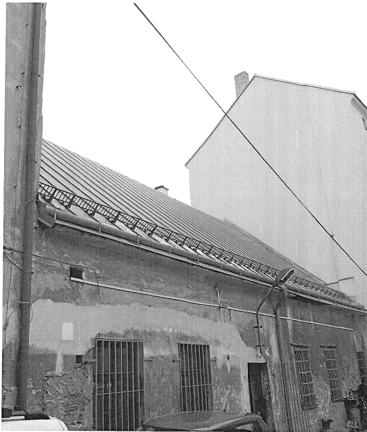
Zadní trakt – objekt 2 (ve výše popsaném textu je záměrem dostavba jednoho klasického nadzemního podlaží.
