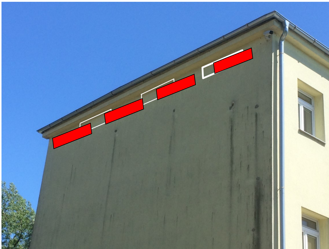
Pohled na severní stranu s vyznačením 3 ks čtyřkomor (obdélníky) 4 ks tříkomor
