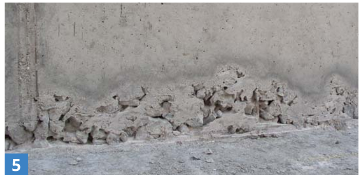
5 Odtok cementového mléka
