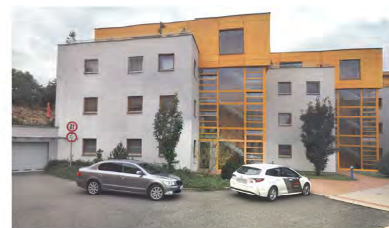
Mláďí 2762/24, 2762/24a 4 podlaží, římsa 12,5 m
