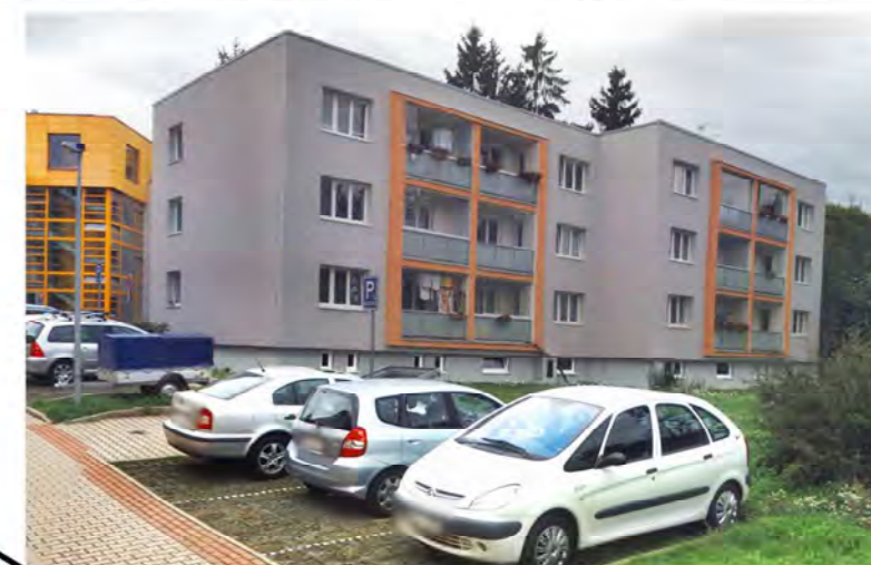
Mláďí 807/22, 808/22a 3 podlaží, římsa 10,5 m
