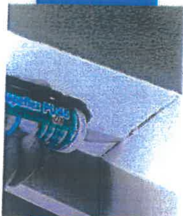
Pružná výplň spár mezi stavebními prvky
