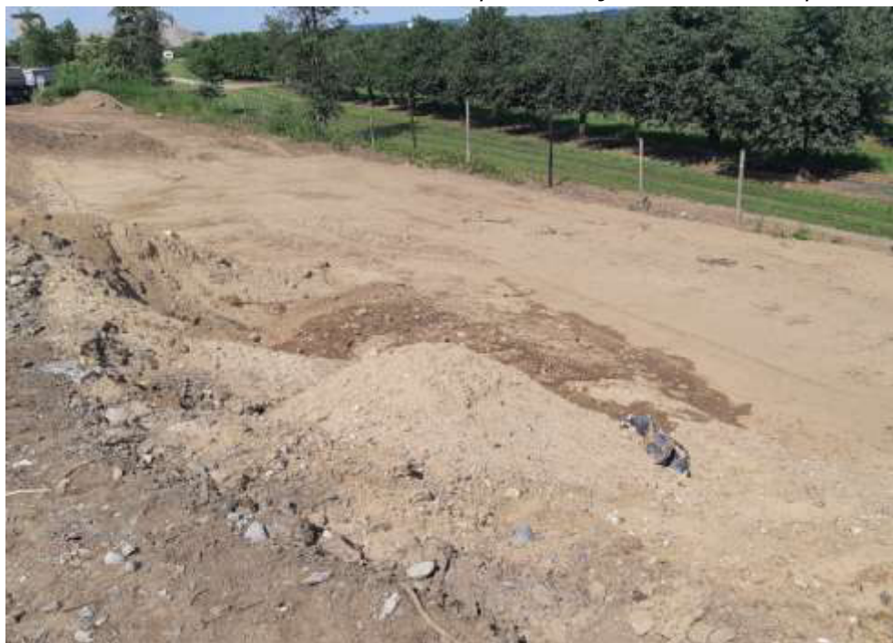
Obr. č. 1 Místo havárie dne 15.6.2020 před zahájením sanačních prací
