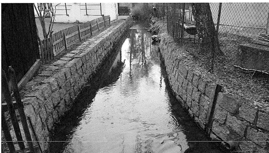
zřízení opevnění pravého břehu v ř. km 11,815 - 11,850 rovnáninou z lomového kamene
