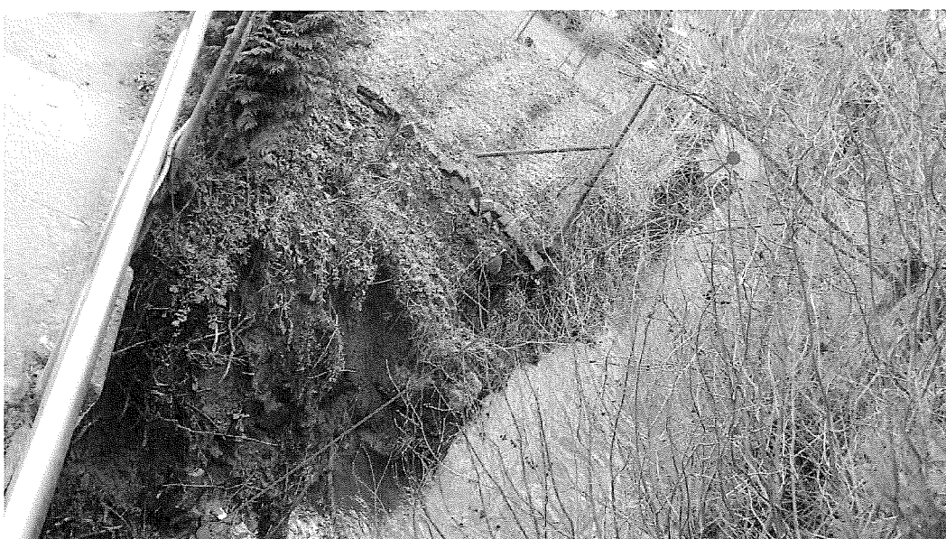
zřízení opevnění pravého břehu v ř. km 11,815 - 11,850 rovnáninou z lomového kamene
