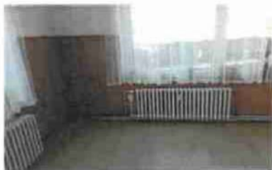
FOTO - STĚNA S KRYTÍM RADIÁTORU 24
