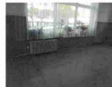
FOTO - STĚNA S KRYTÍM RADIÁTORU 25
