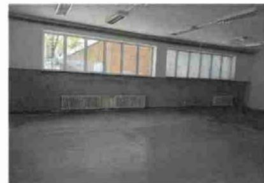
FOTO - STĚNA S KRYTÍM RADIÁTORU 26
