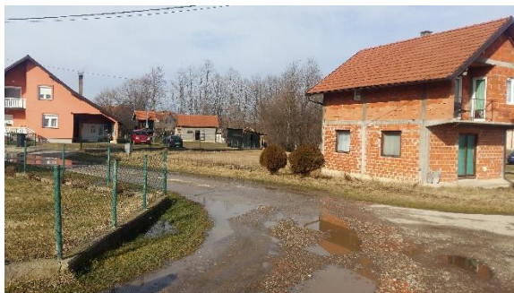
Obr. 15 Fotografie z místního šetření, pohled na prostor pro umístění čerpací stanice ČS3 (PS3)
